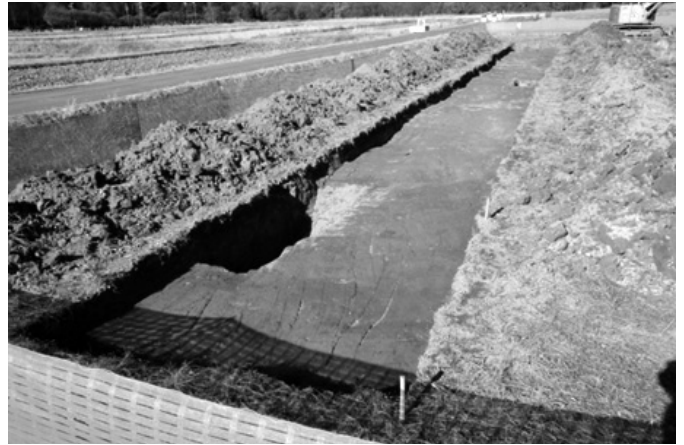
5区2トレンチ (南から)
