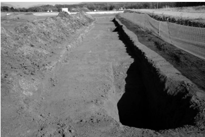
1区1トレンチ(南から)
