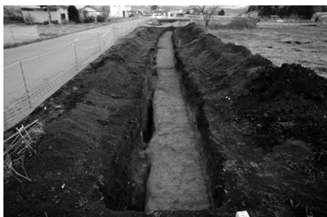
2区トレンチ(西から)
