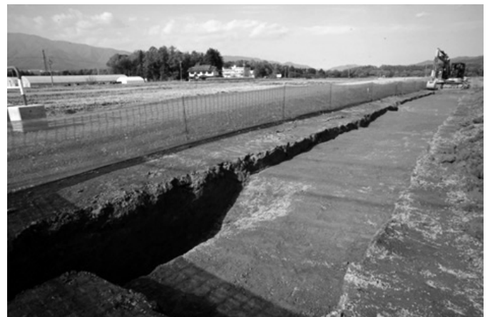
1区2トレンチ(南から)
