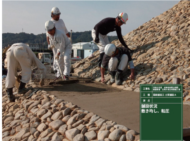
R1 園路舗装工 段築テラス (小段) 土質舗装状況
