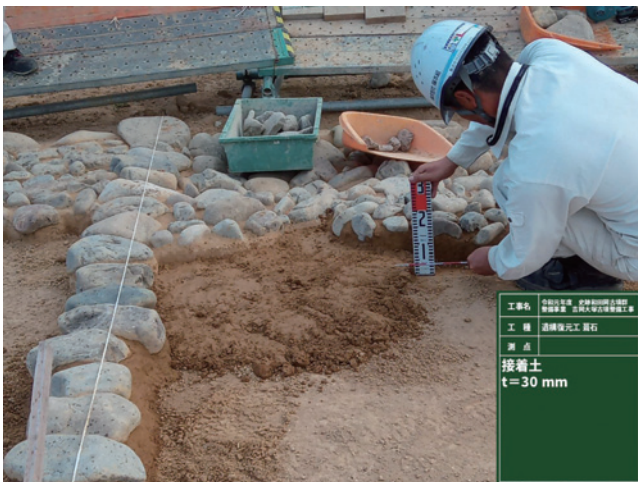
R1 遺構復元工 下段葺石工 接着土施工状況
