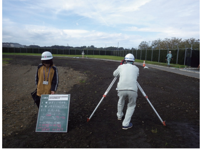
H29 舗装工 (下層路盤) 完成検査 (史跡管理道 B) (1)
