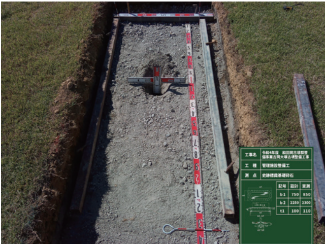
R4 管理施設整備工 史跡標識基礎砕石
