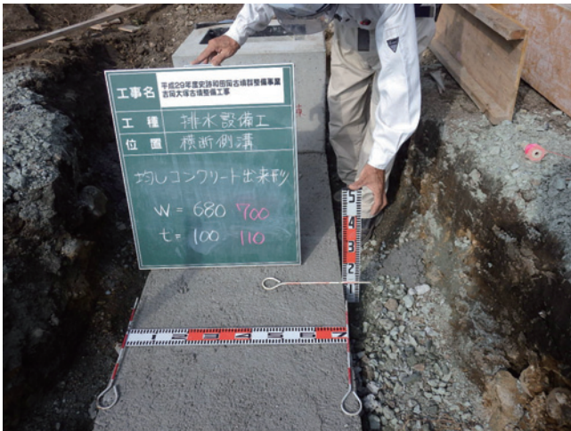
H29 排水設備工 均しコンクリート出来形
