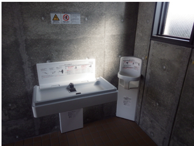
R3 機械設備工 竣工 (2)
