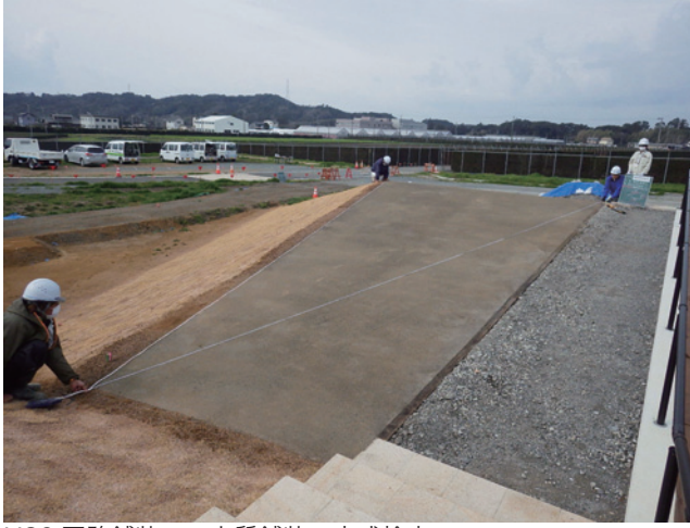
H30 園路舗装工 土質舗装 完成検査
