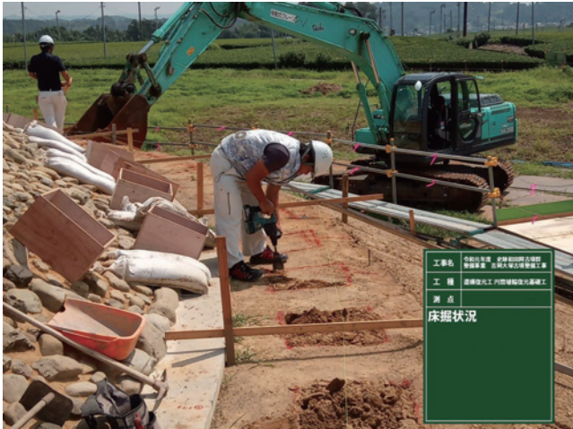
R1 遺構復元工 埴輪復元基層工 床掘削状況
