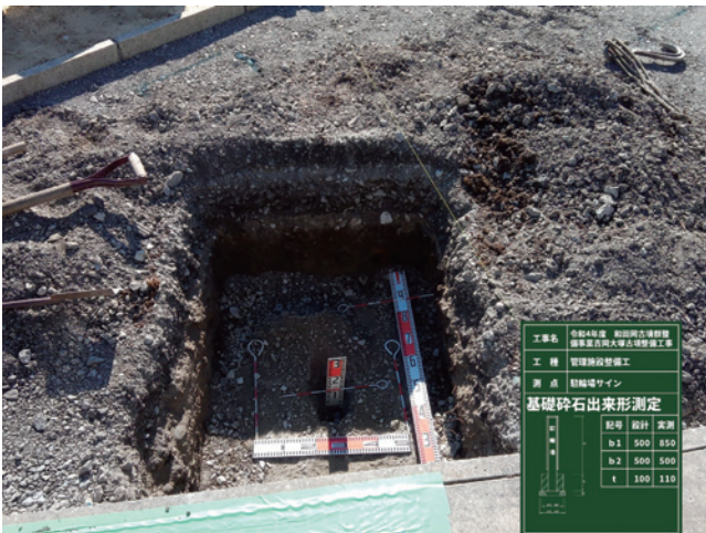
R4 管理施設整備工 駐輪場サイン基礎砕石出来形測定
