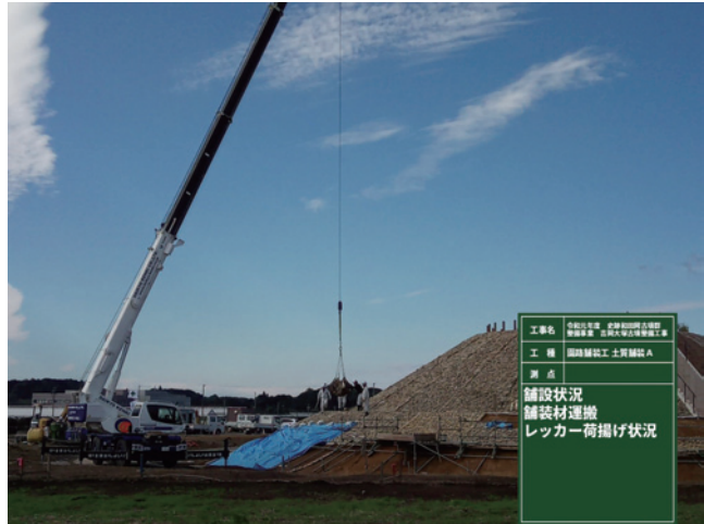
R1 園路舗装工 段築テラス (小段) 土質舗装 レッカー荷揚げ状況
