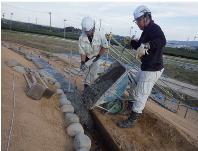
H30 遺構復元工 上段葺石(基底石)基礎型枠コンクリート流し込み
