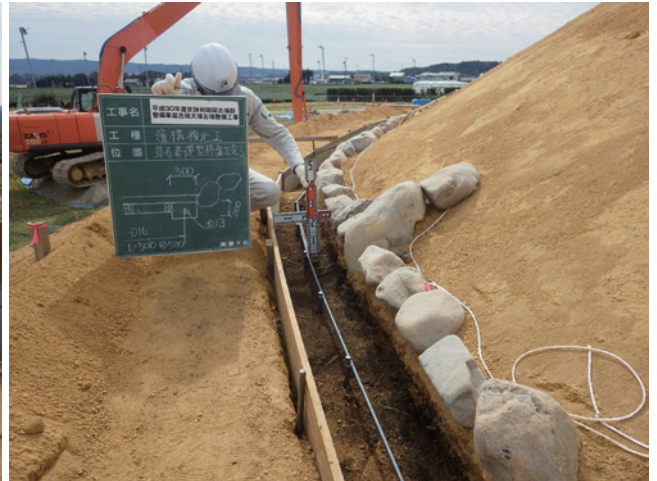
H30 遺構復元工 上段葺石(基底石)基礎型枠
