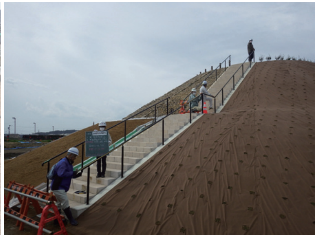
H30 管理施設工 手摺り 完成検査
