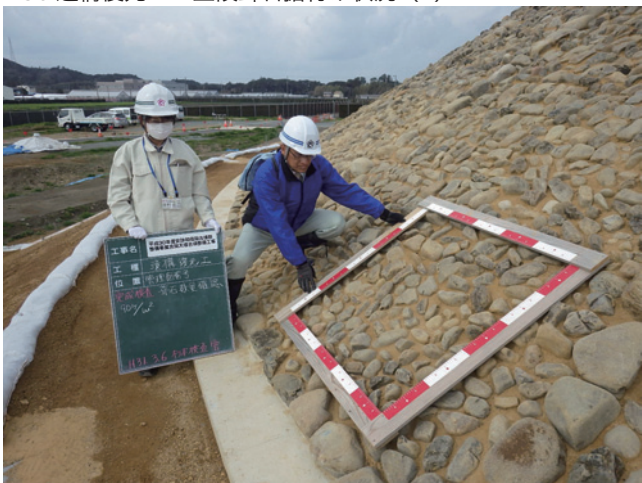
H30 遺構復元工 上段葺石工 完成検査
