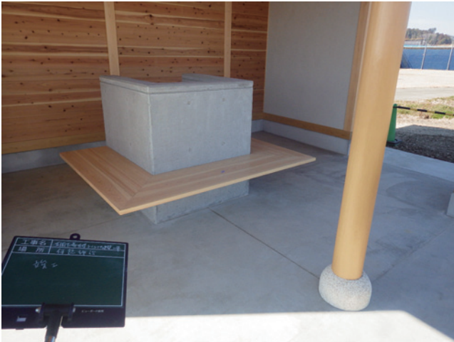
R3 休憩施設 竣工 (2)
