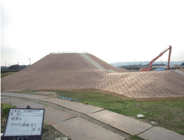
H30 植栽工 クラピア植栽出来形 (2)
