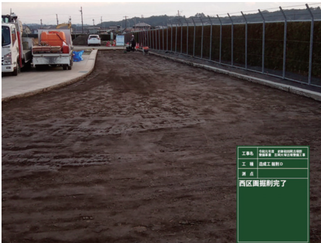
R1 造成工 多目的広場西側区画掘削完了
