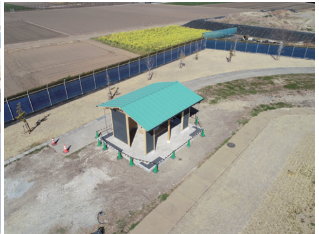
R3 休憩施設 竣工 (3)
