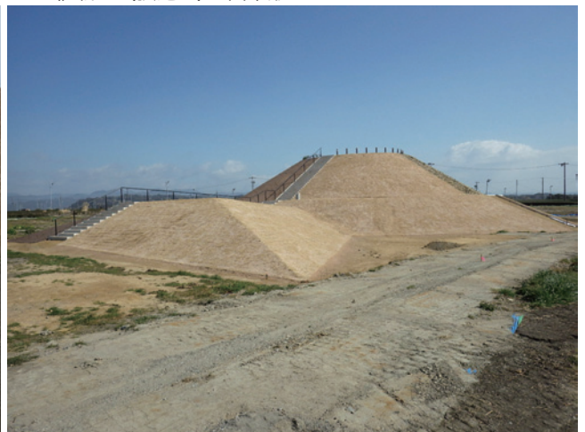
H30 植栽工 完成
