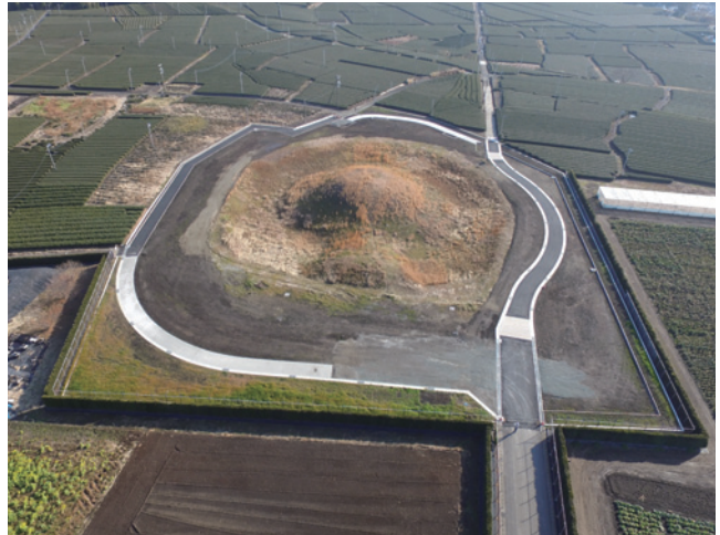
H29 完成 (西側)
