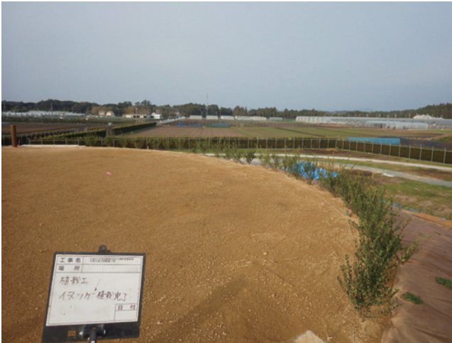
H30 植栽工 イヌツグ植栽出来形
