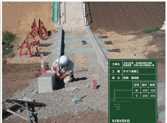
R1 階段工（手摺工）南側階段部
