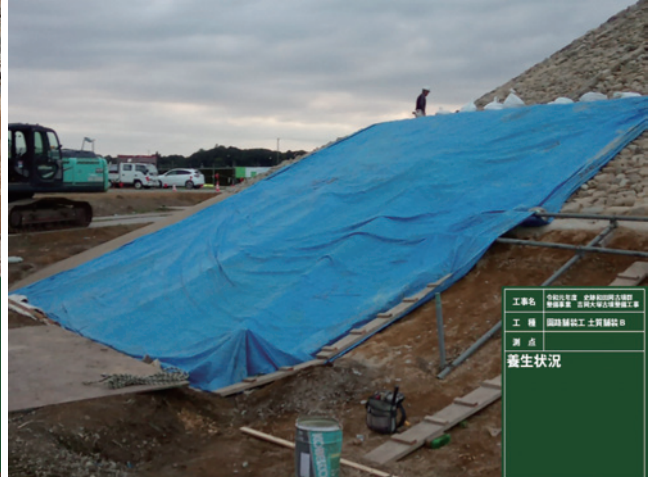
R1 園路舗装工 後円部法尻部 土質舗装 養生状況 (2)
