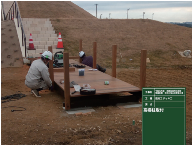
R1 園路工（デッキ工）高欄取付状況
