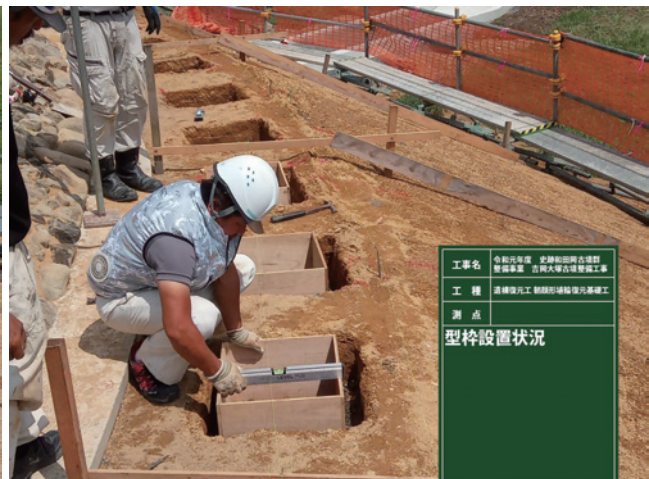
R1 遺構復元工 埴輪復元基層工 型枠設置状況
