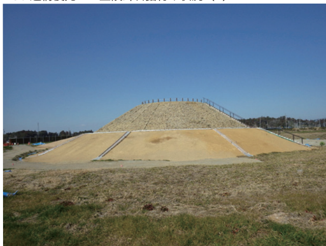
H30 遺構復元工 完成
