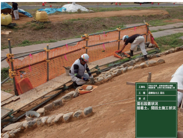
R1 遺構復元工 下段葺石設置状況 (1)
