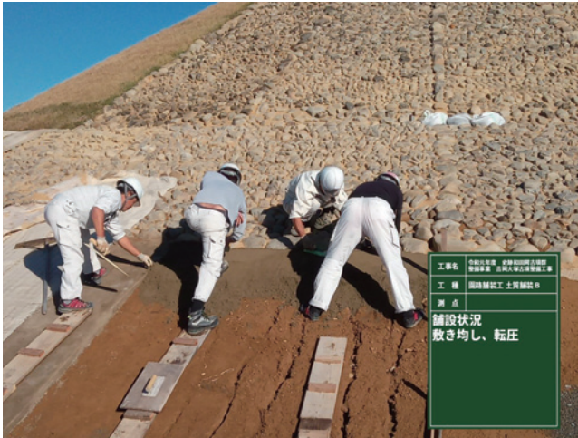
R1 園路舗装工 後円部法尻部 土質舗装 敷き均し
