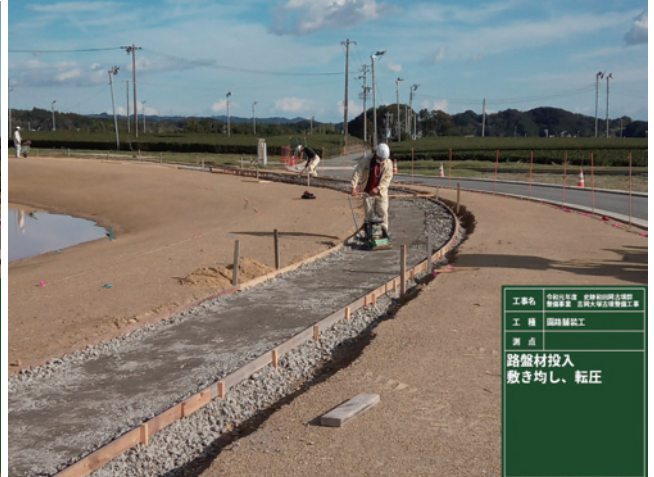
R1 園路舗装工 (周遊路) 路盤材投入
