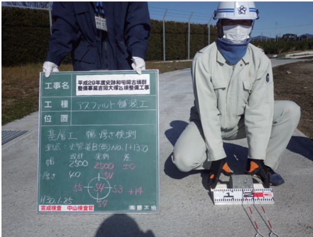
H29 アスファルト舗装工 完成検査 (史跡管理道B)
