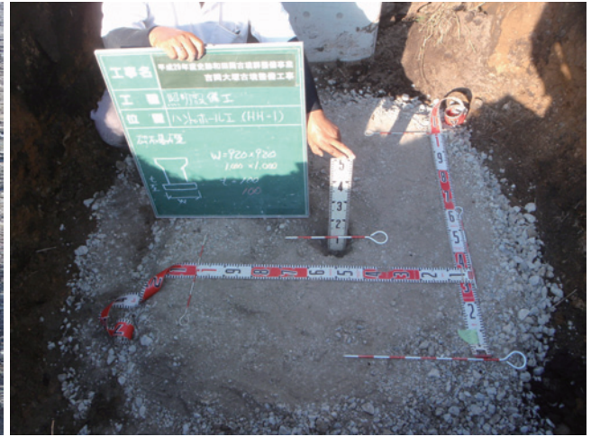
H29 電気設備整備工 ハンドホール工碎石基礎 (HH-1)
