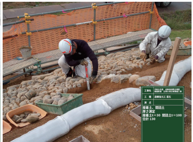
R1 遺構復元工 下段葺石工 間詰土施工状況
