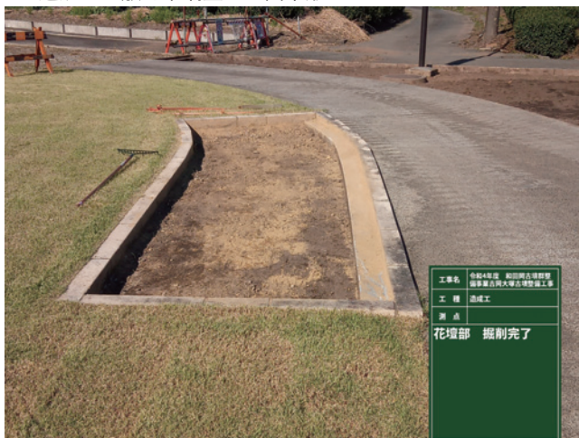
R4 園路工 花壇部掘削完了
