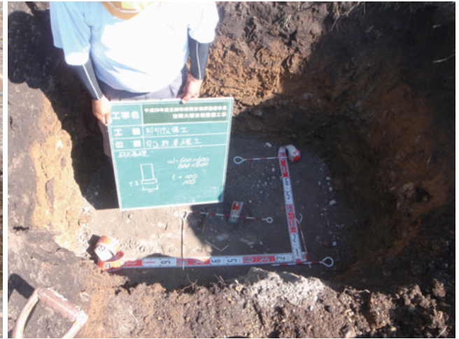
H29 電気設備整備工 引込柱基礎工碎石基礎
