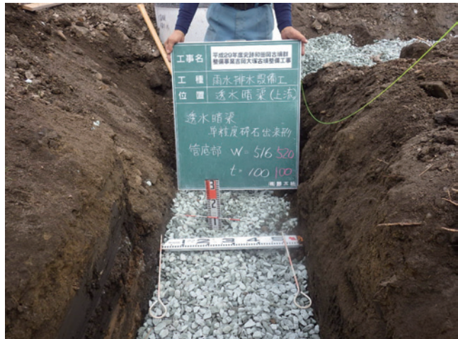
H29 雨水排水設備工 単粒度碎石出来形 (透水暗渠)
