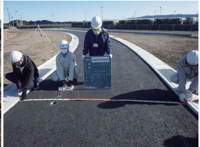
H29 アスファルト舗装工 完成検査 (史跡管理道A)
