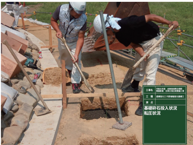
R1 遺構復元工 埴輪復元基層工 碎石投入及び転圧
