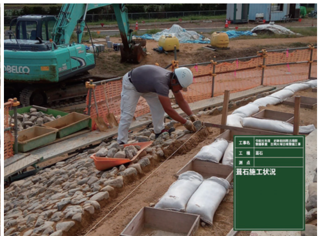
R1 遺構復元工 下段葺石設置状況 (2)
