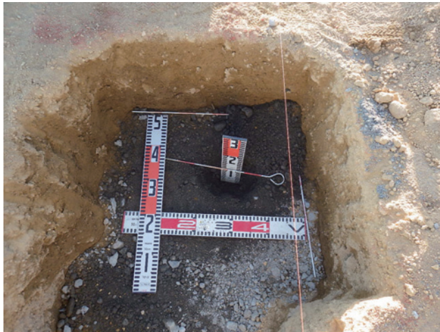
H30 管理施設工 口ノ柵基礎砕石
