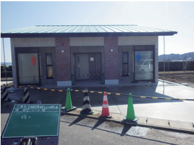
R3 トイレ 竣工 (1)
