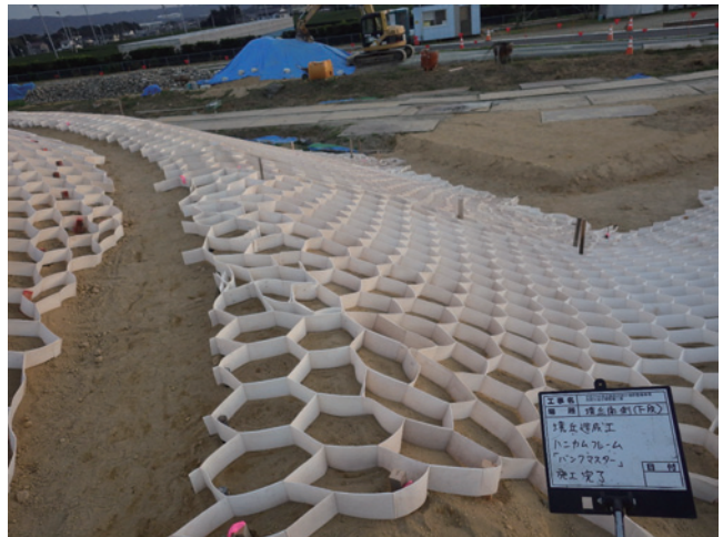
H30 填丘造成工 ハニカムフレーム出来形
