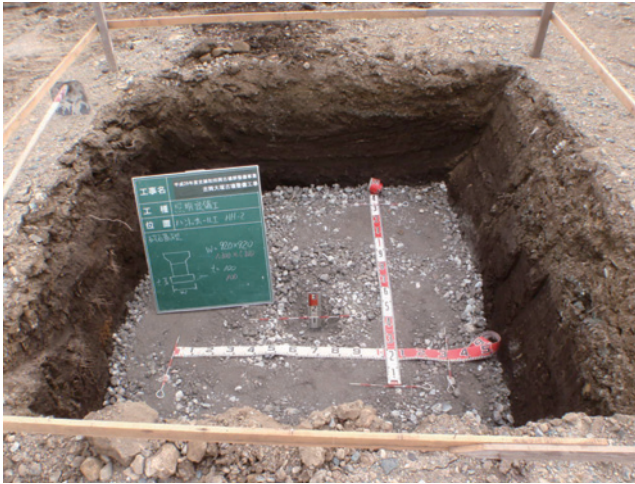
H29 電気設備整備工 ハンドホール工碎石基礎 (HH-2)
