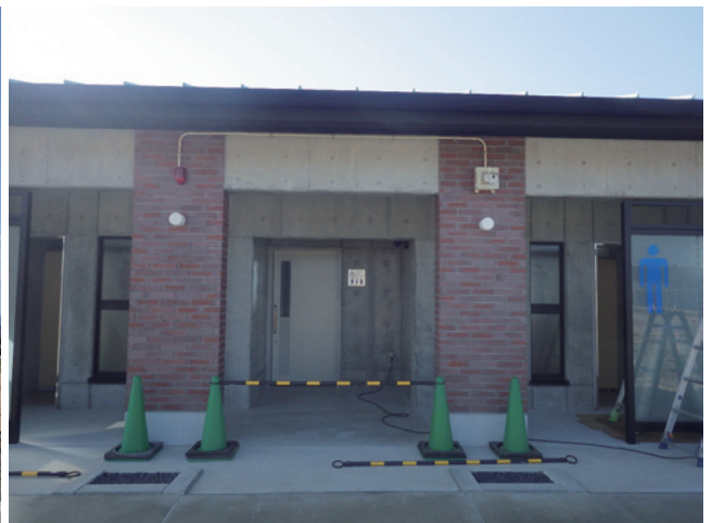
R3 電気設備工 防犯カメラ設置
