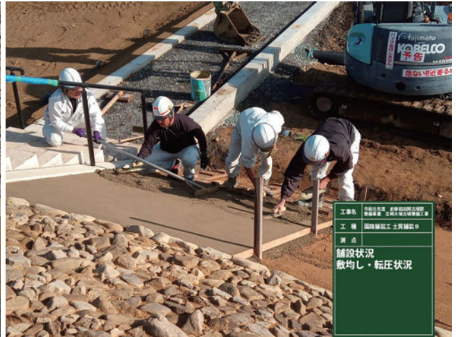
R1 園路舗装工 後円部法尻部 土質舗装 転圧
