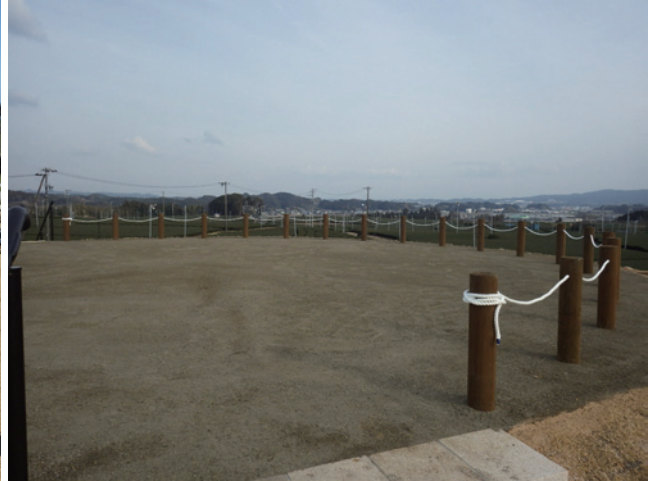
H30 管理施設工 ロープ柵完了
