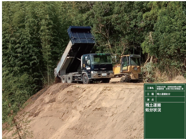
R1 造成工 残土処分状況
