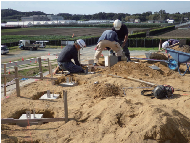
H30 管理施設工 口ノ柵基礎設置状況
