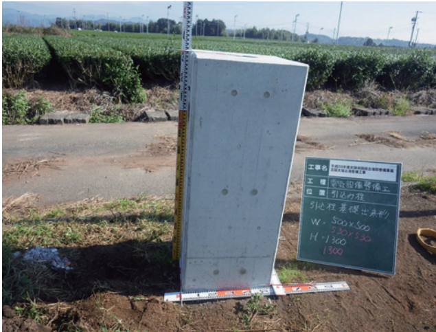
H29 電気設備整備工 引込柱基礎出来形
