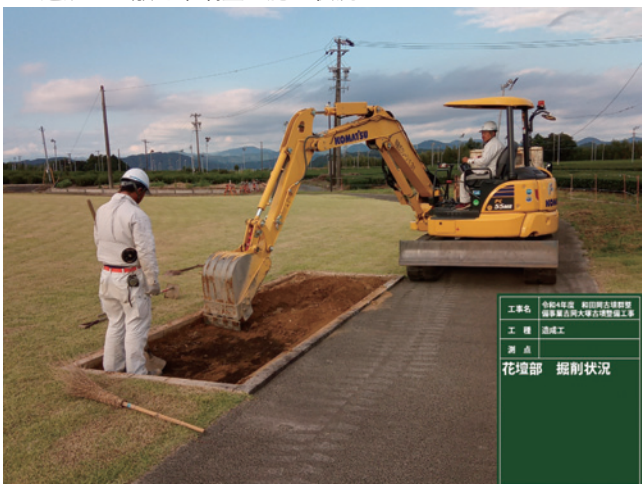
R4 園路工 花壇部掘削状況
