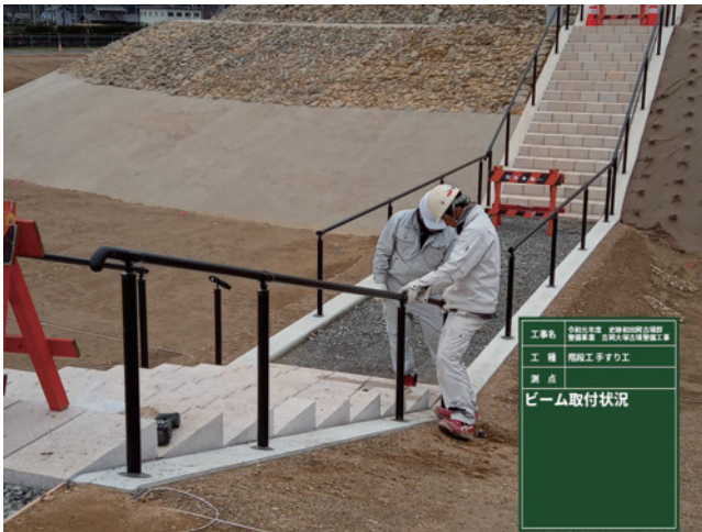
R1 階段工（手摺工）ビーム取付状況
