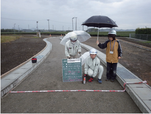
H29 舗装工 (下層路盤) 完成検査 (史跡管理道 A)
