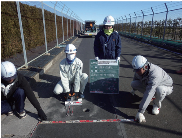
H29 給水整備工 (表層工) 幅、厚さ計測 No.6
