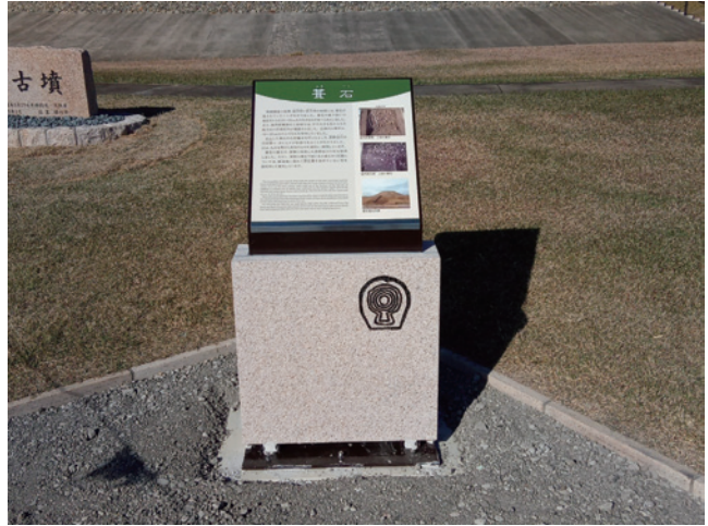
R4 管理施設整備工（解説板工） 施工状況
