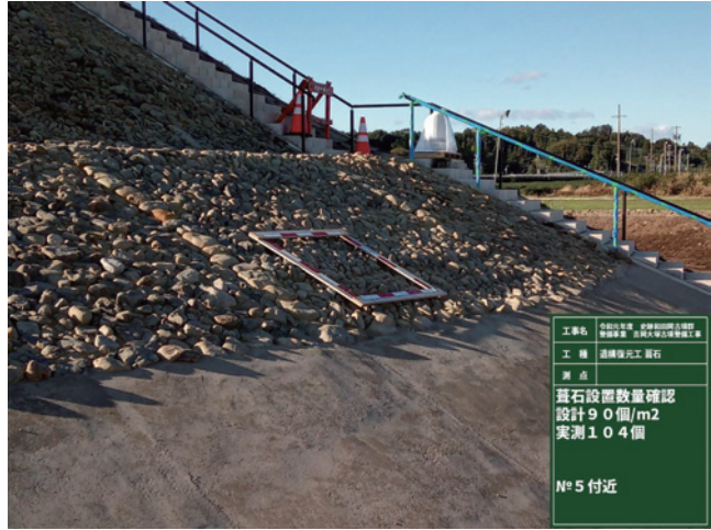
R1 遺構復元工 下段葺石工出来形
