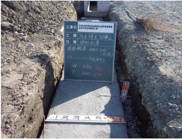
H29 雨水排水設備工 均しコンクリート出来形
