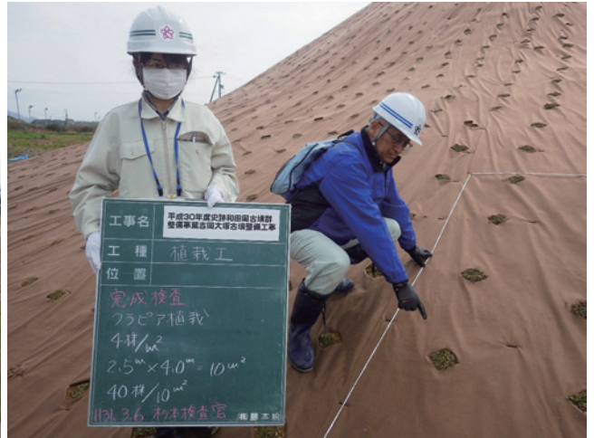
H30 植栽工 クラピア植栽 完成検査
