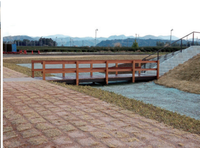
R1 園路工（デッキ工）設置完了
