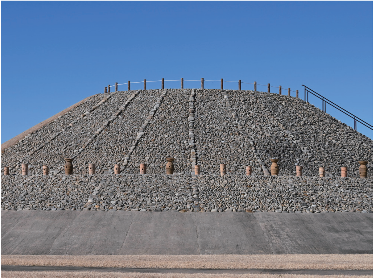
埴輪列の復元された後円部（南東から）
