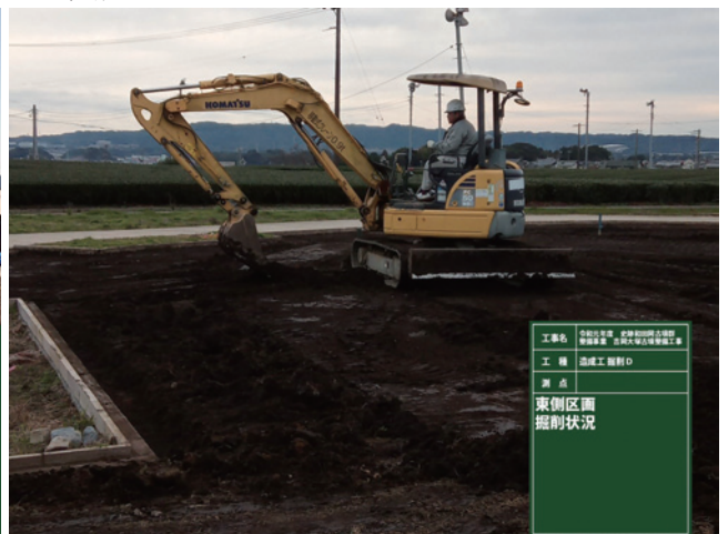
R1 造成工 多目的広場東側区画掘削状況
