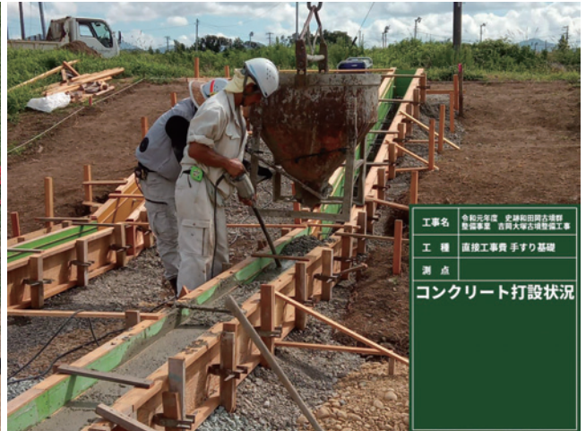
R1 階段工（手摺工）コンクリート打設状況
