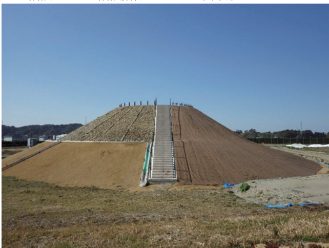
H30 階段工 竣工
