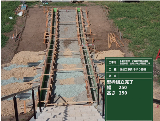
R1 階段工（手摺工）型枠組立完了
