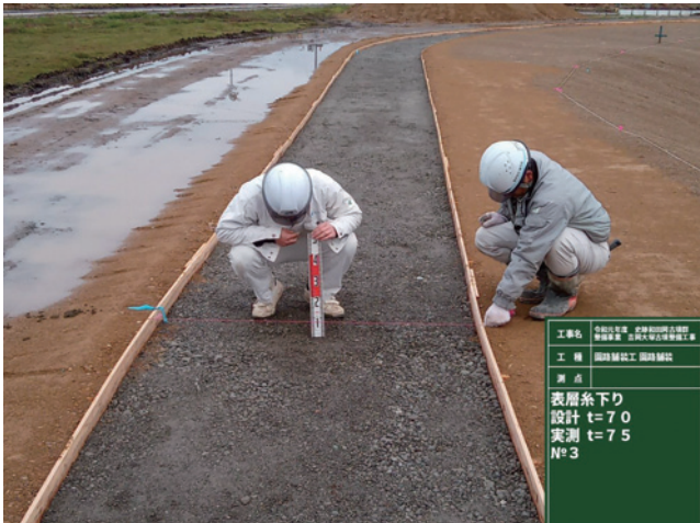
R1 園路舗装工 (周遊路) 表層工 出来形計測
