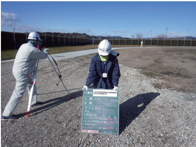
H29 排水設備工 (側溝工) 基準高測定
