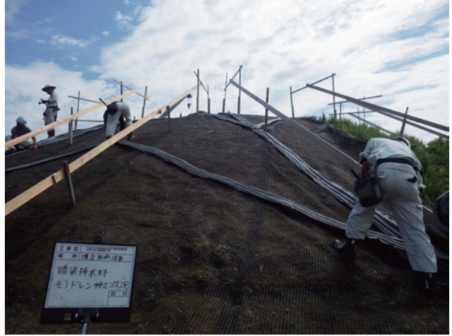
H30 填丘造成工 暗渠排水材施工状況
