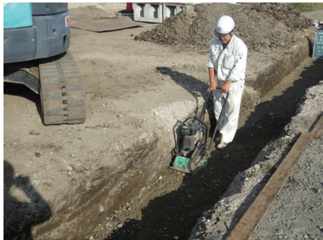
H29 排水設備工の様子
