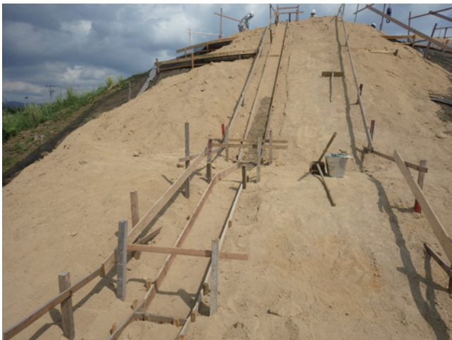
H30 階段工 丁張状況
