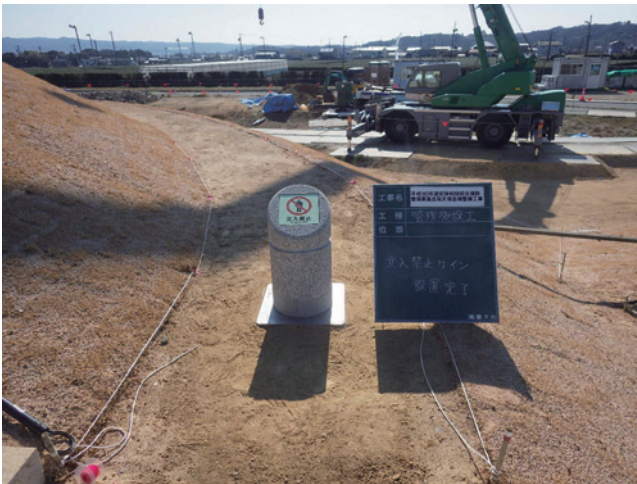
H30 管理施設工 立入禁止サイン設置完了
