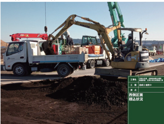
R1 造成工 多目的広場西側区画積込状況
