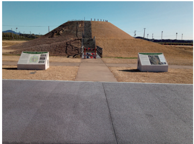
R4 管理施設整備工（説明板工） 施工状況（2）
