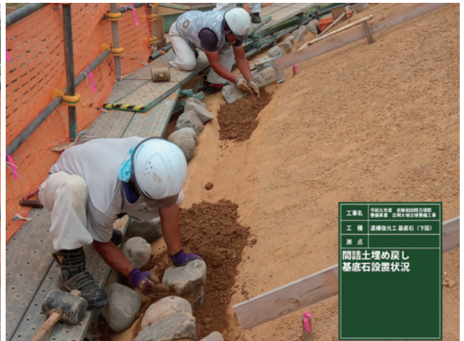
R1 遺構復元工 下段葺石工 基礎石設置状況
