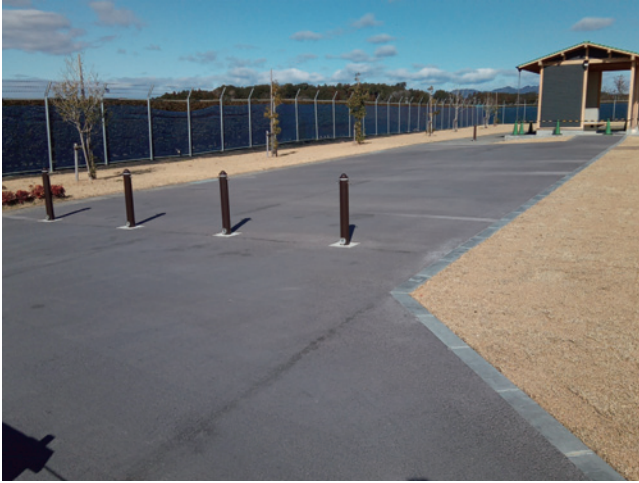
R4 園路舗装工 古墳西側広場施工状況 (1) 南から
