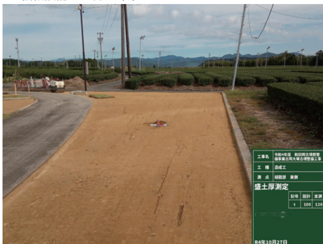
R4 造成工 敷地東端盛土工出来形
