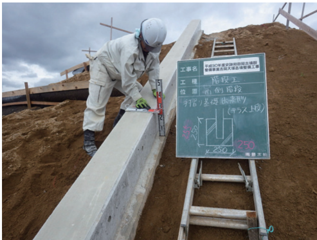
H30 階段工 手摺工基礎出来形 (テラス上段)
