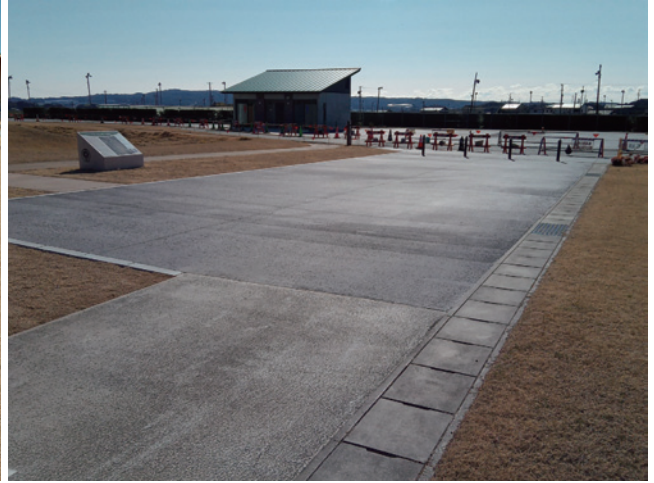
R4 園路舗装工 古墳西側広場施工状況 (2) 北から
