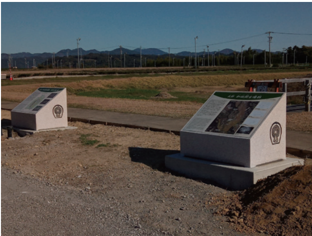
R4 管理施設整備工（説明板工） 施工状況（1）
