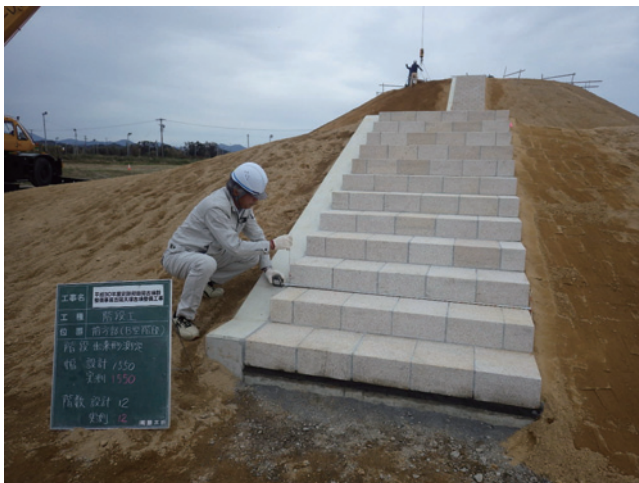
H30 階段工 B型階段出来形測定 (前方部)
