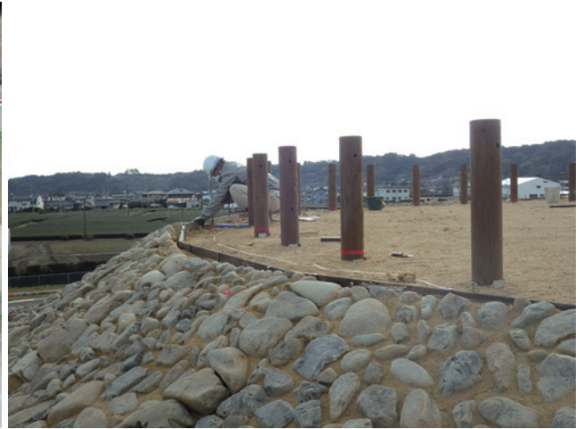
H30 園路舗装工 土質舗装型枠組立
