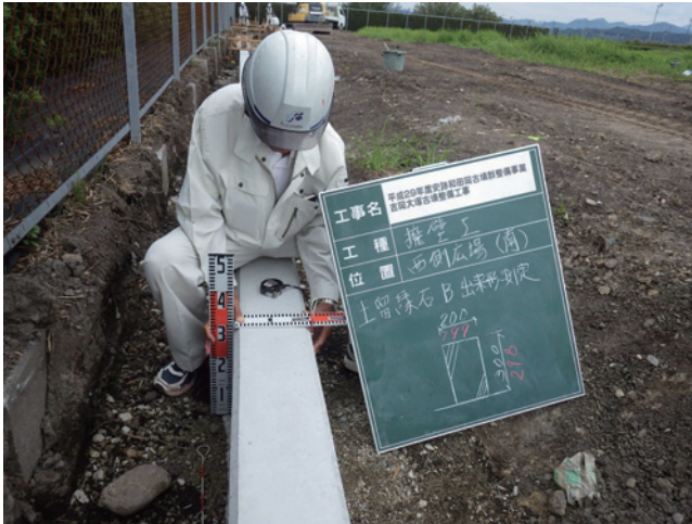
H29 敷地造成工 (擁壁工) 土墨緑石 B 出来形測定
