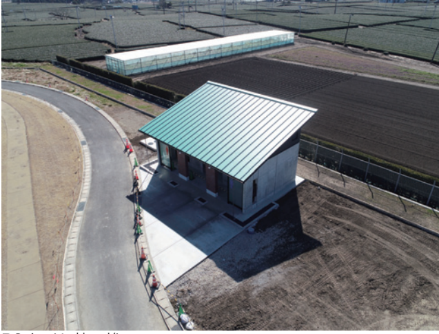
R3 トイレ棟 竣工
