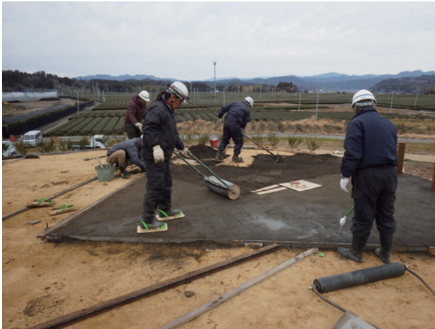
H30 園路舗装工 土質舗装施工状況
