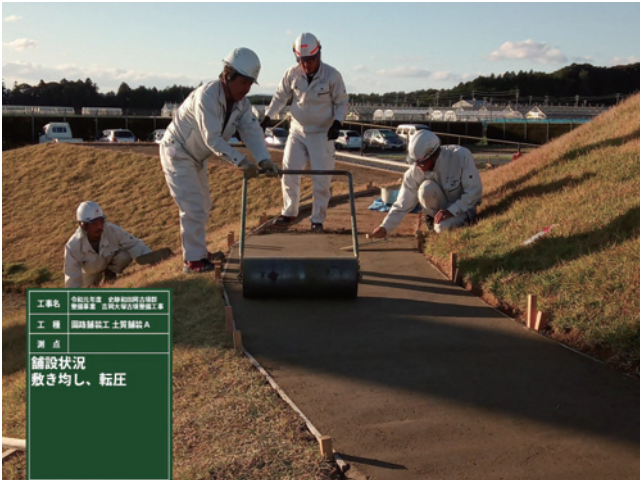
R1 園路舗装工 段築テラス (小段) 土質舗装転圧状況 (1)
