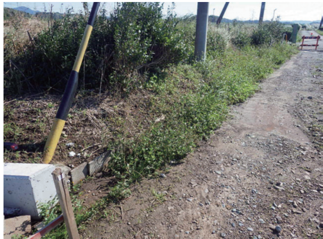
H29 排水設備工 施工前
