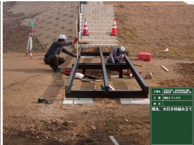
R1 園路工（デッキ工）根太、大引き材組立状況
