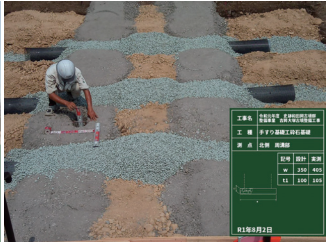
R1 階段工（手摺基礎工）基礎砕石
