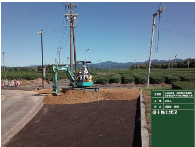
R4 造成工 敷地東端盛土施工状況
