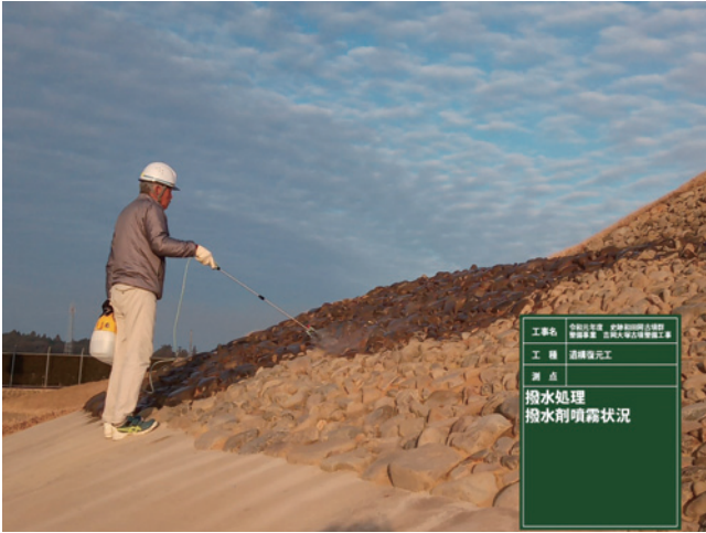
R1 遺構復元工 下段葺石工 撥水処理施工状況
