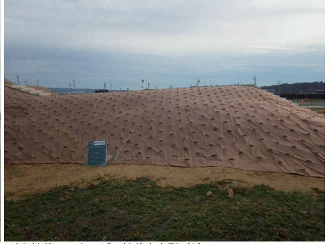
H30 植栽工 クラピア植栽出来形 (1)
