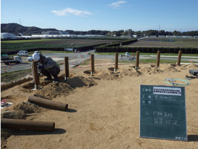
H30 管理施設工 ロープ支柱設置状況
