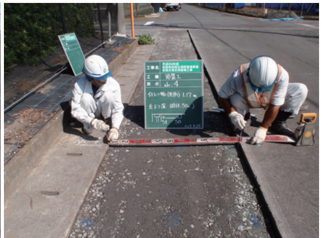
H29 給水整備工 (路盤工) 仕上り幅 (実測) 測点 No.4
