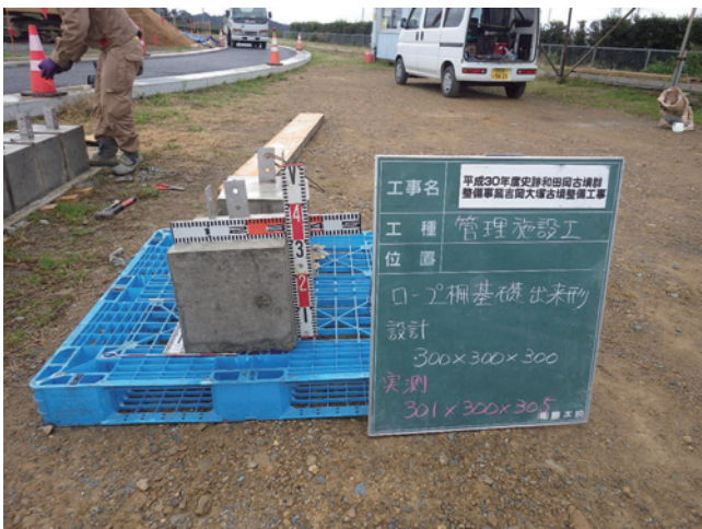
H30 管理施設工 口ノ柵基礎出来形
