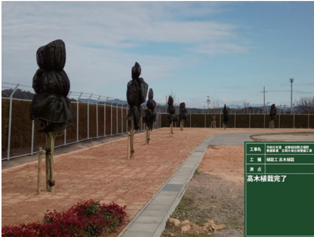
R1 植栽工 高木植栽出来形
