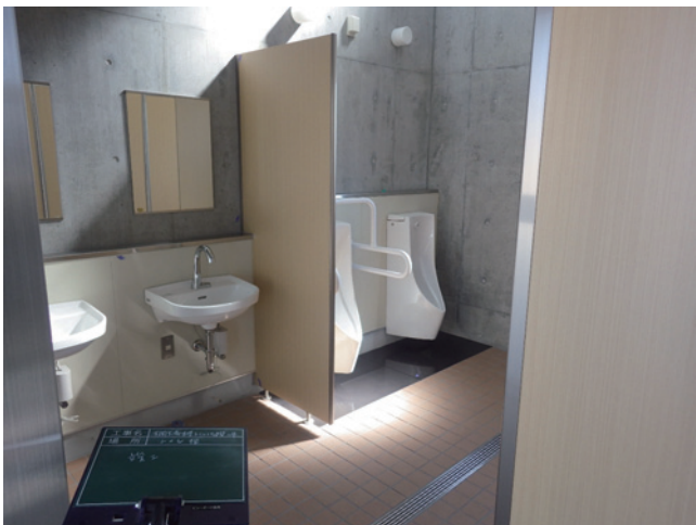
R3 機械設備工 竣工 (1)
