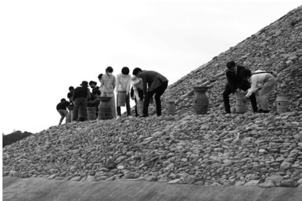
第 101 図 竣工式での埴輪設置
