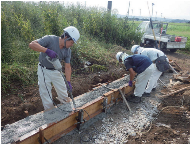
H29 敷地造成工の様子
