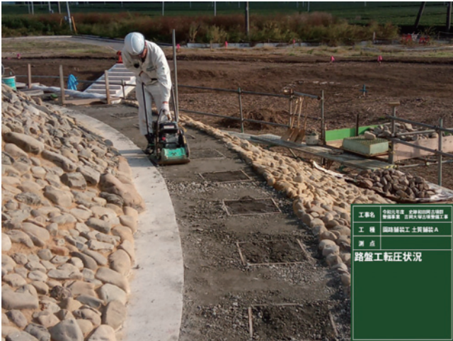
R1 園路舗装工 段築テラス (小段) 路盤工転圧状況
