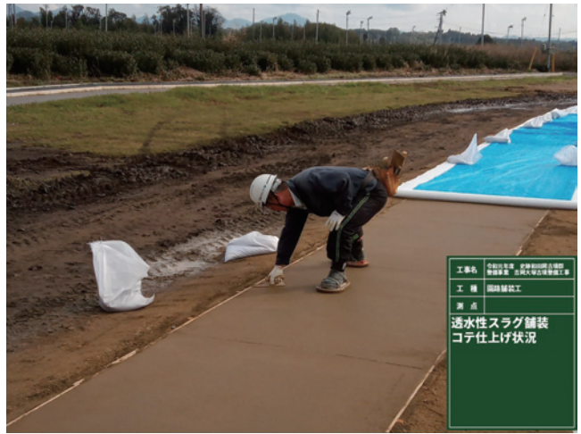
R1 園路舗装工（周遊路）透水性スラグ舗装 コテ仕上げ状況
