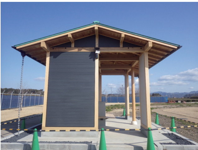
R3 電気設備工 ソーラー式 LED センサーライト設置
