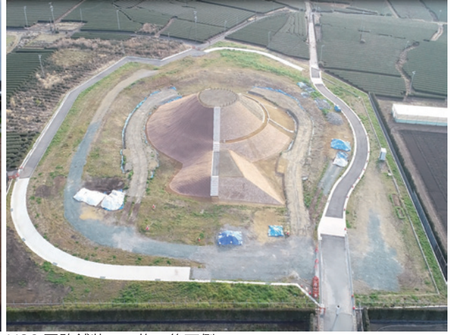
H30 園路舗装工 施工後西側
