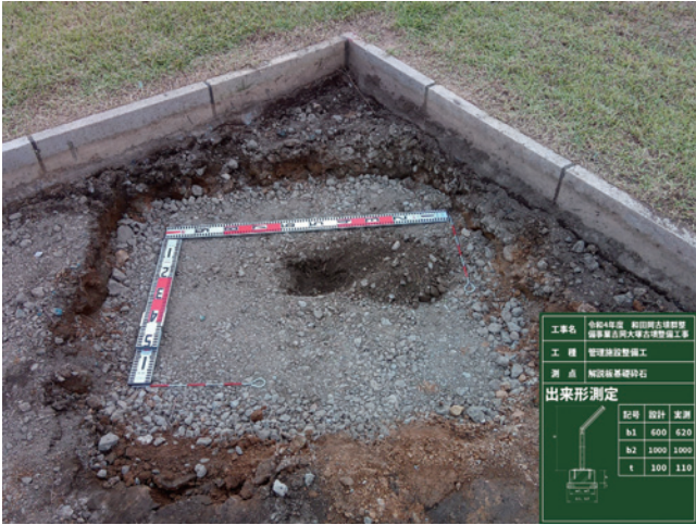
R4 管理施設整備工 解説板基礎砕石出来形測定
