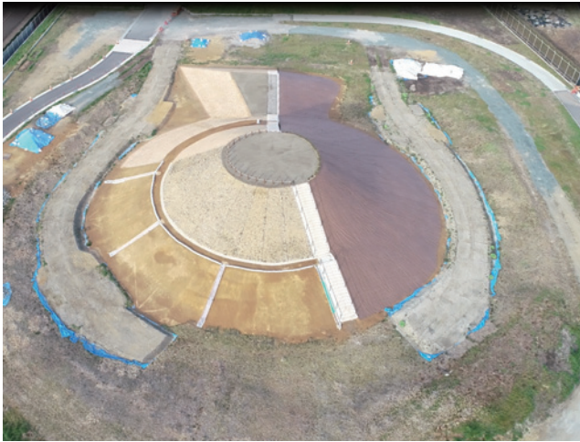
H30 園路舗装工 施工後東側
