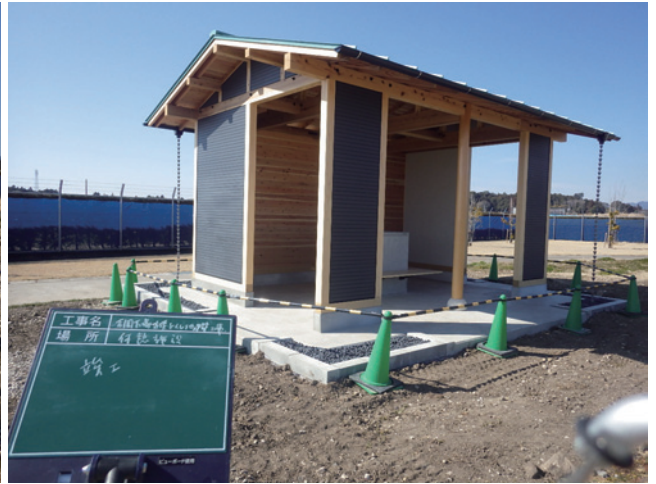
R3 休憩施設 竣工 (1)
