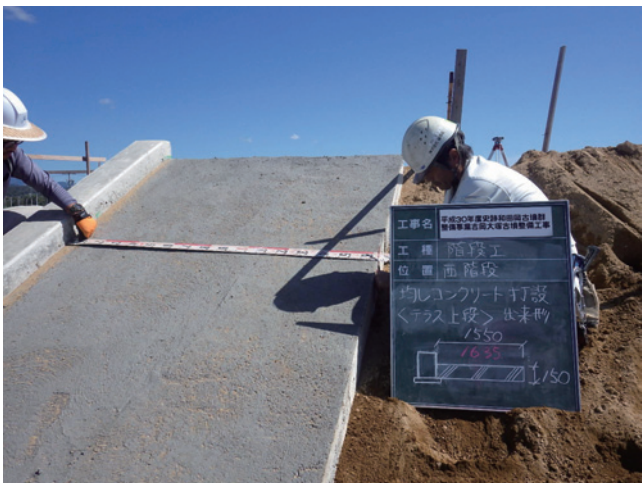
H30 階段工 均しコンクリート出来形 (テラス上段)
