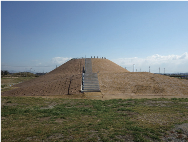
H30 管理施設工 竣工
