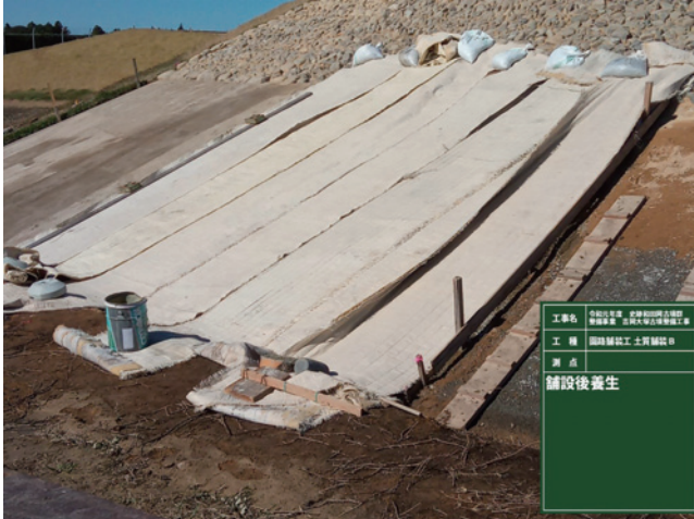
R1 園路舗装工 後円部法尻部 土質舗装 養生状況 (1)
