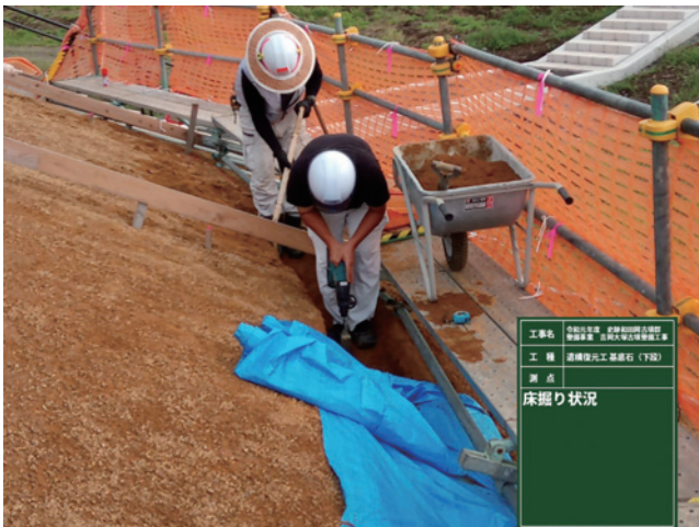
R1 遺構復元工 下段葺石工 (基礎石) 床掘り状況
