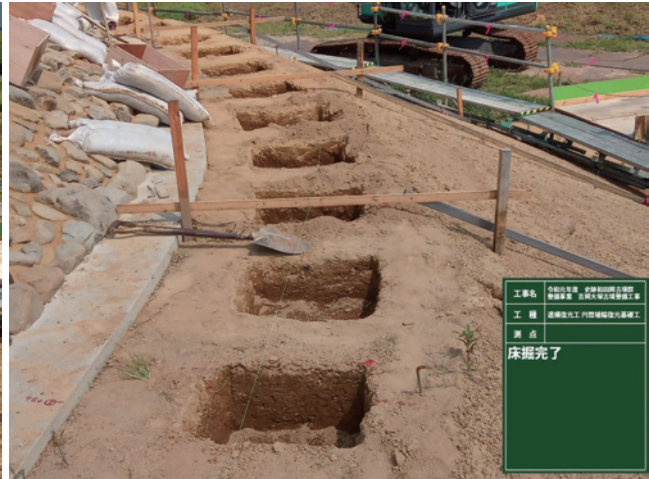
R1 遺構復元工 埴輪復元基層工 床掘削完了
