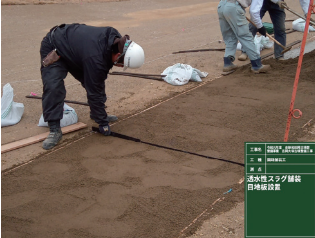
R1 園路舗装工（周遊路）透水性スラグ舗装 目地板設置
