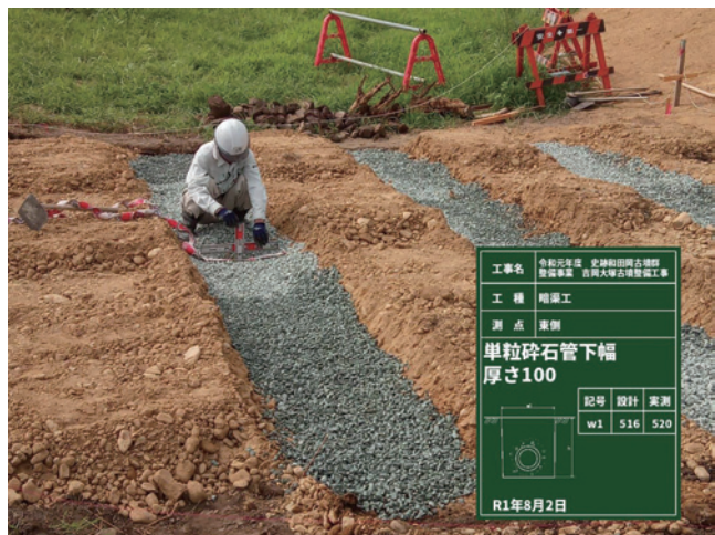
R1 排水設備工（暗渠工） 単粒砕石敷均し状況
