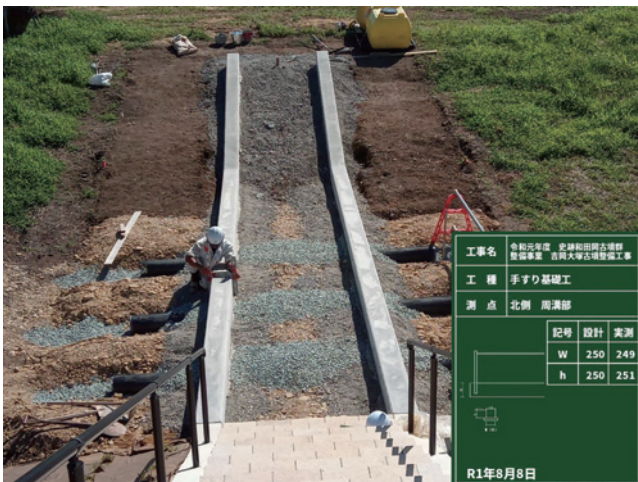
R1 階段工（手摺工）北側周溝部分基礎状況
