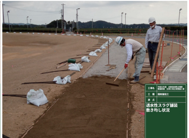
R1 園路舗装工 (周遊路) 透水性スラグ舗装 敷き均し状況
