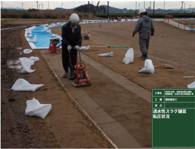
R1 園路舗装工（周遊路）透水性スラグ舗装 転圧状況
