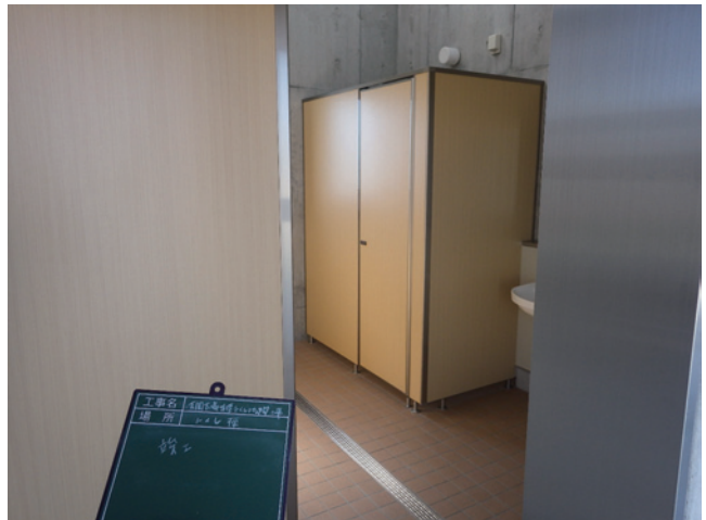
R3 トイレ 竣工 (2)
