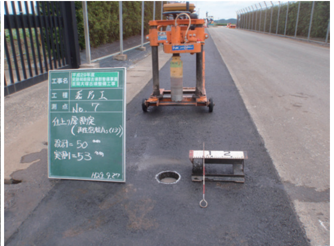
H29 給水整備工 (表層工) 仕上り厚測定 No.7
