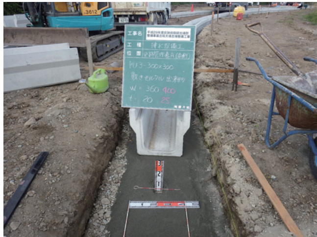
H29 排水設備工 敷きモルタル出来形 (史跡管理道 A)
