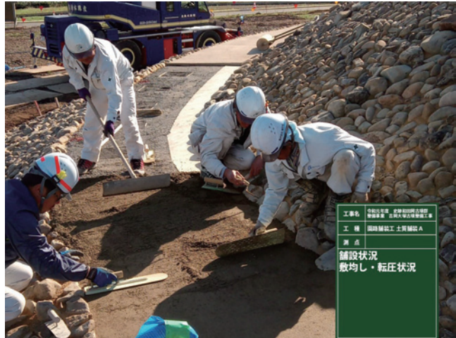
R1 園路舗装工 段築テラス (小段) 土質舗装転圧状況 (2)
