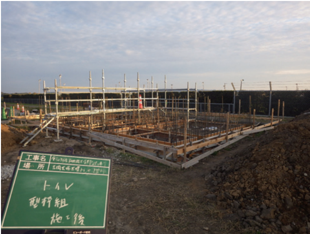
R3 トイレ 型枠組施工後
