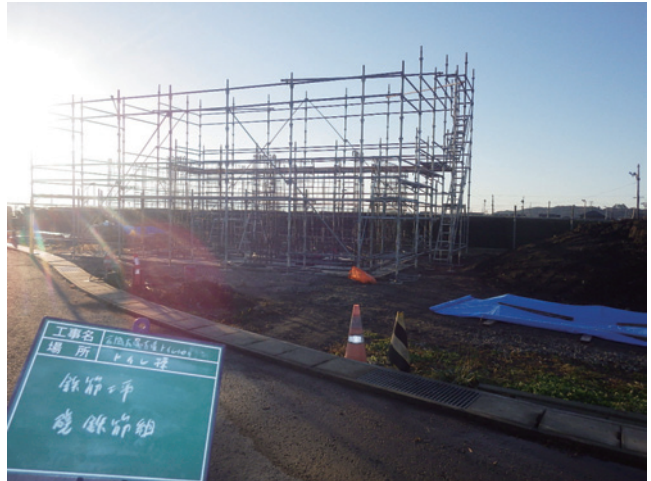
R3 トイレ（鉄筋工事） 壁鉄筋組
