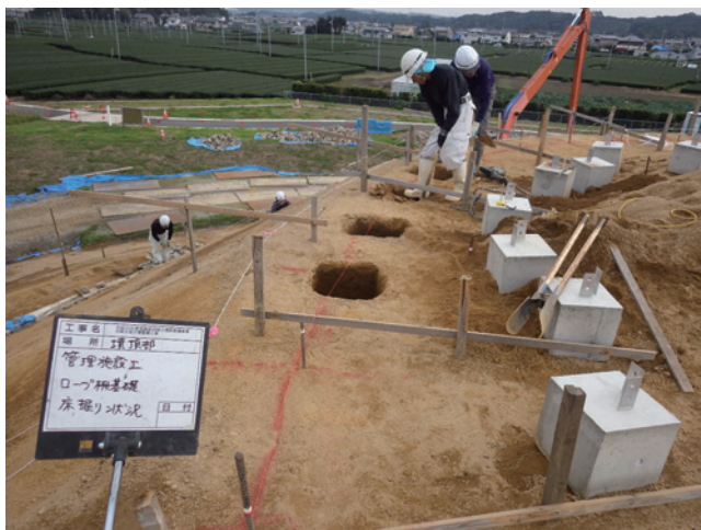
H30 管理施設工 口ノ柵基礎穴掘削状況
