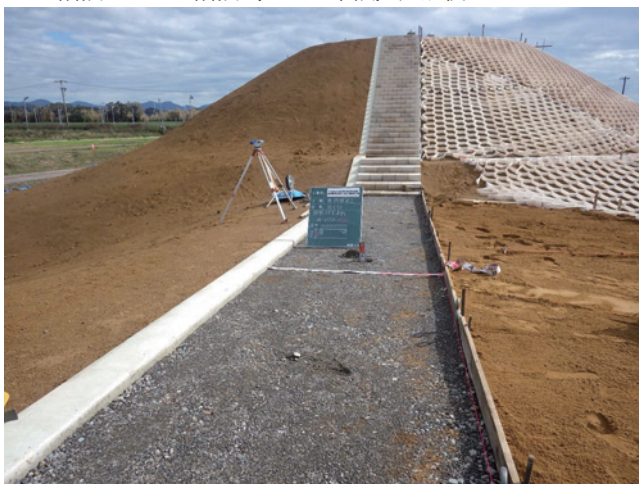
H30 园路舗装工 路盤材出来形 (前方部)
