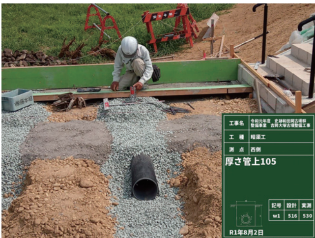
R1 排水設備工（暗渠工） 施工状況
