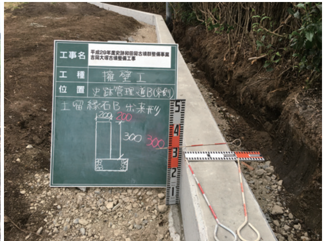
H29 敷地造成工 (擁壁工) 土墨緑石 B 出来形
