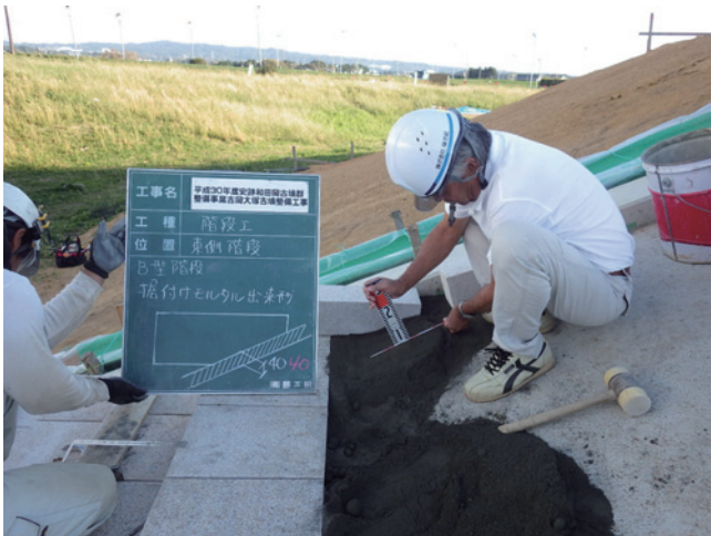
H30 階段工 B型階段据付けモルタル出来形
