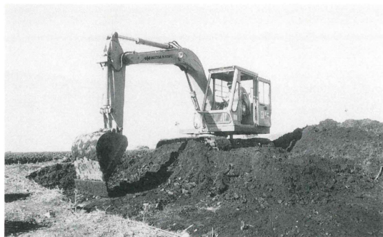
重機稼働風景
