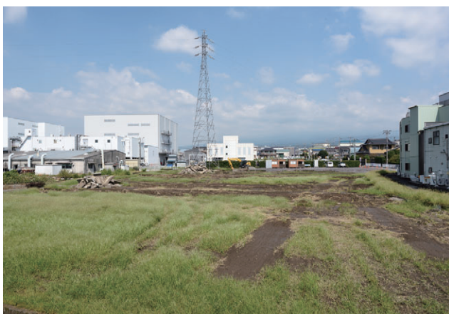
2. 調査前全景（南から）
