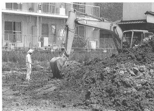
重機による表土除去
