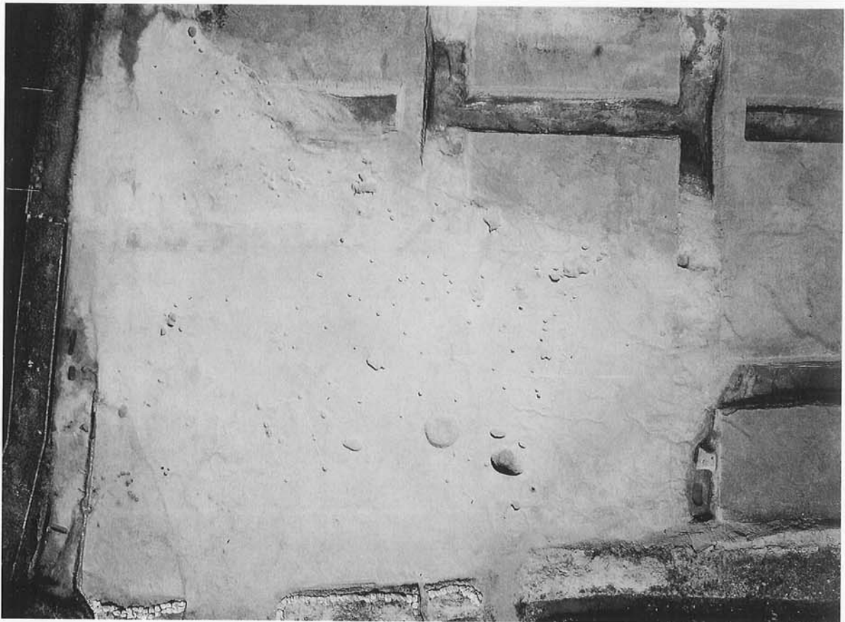
2地区西側（南より）
