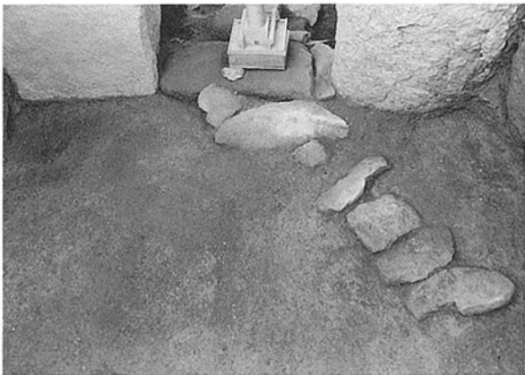
14号墳玄室内排水施設
