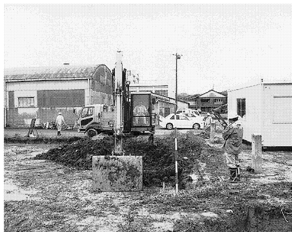
重機による表土除去
