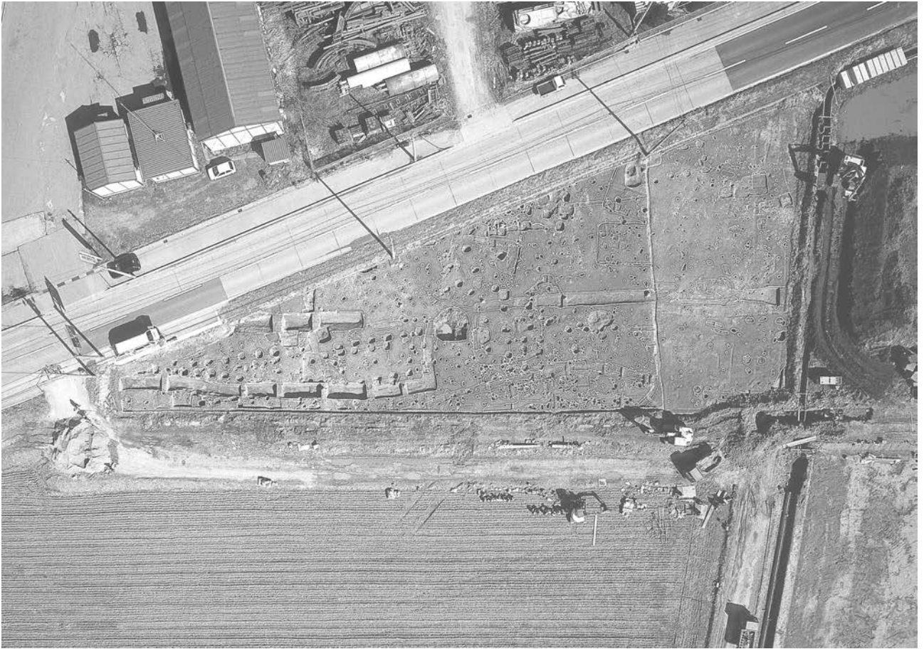
(1) 3区 調査区全景
