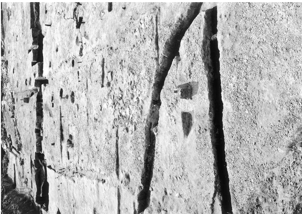
(2) 舗装道路 (東より)
