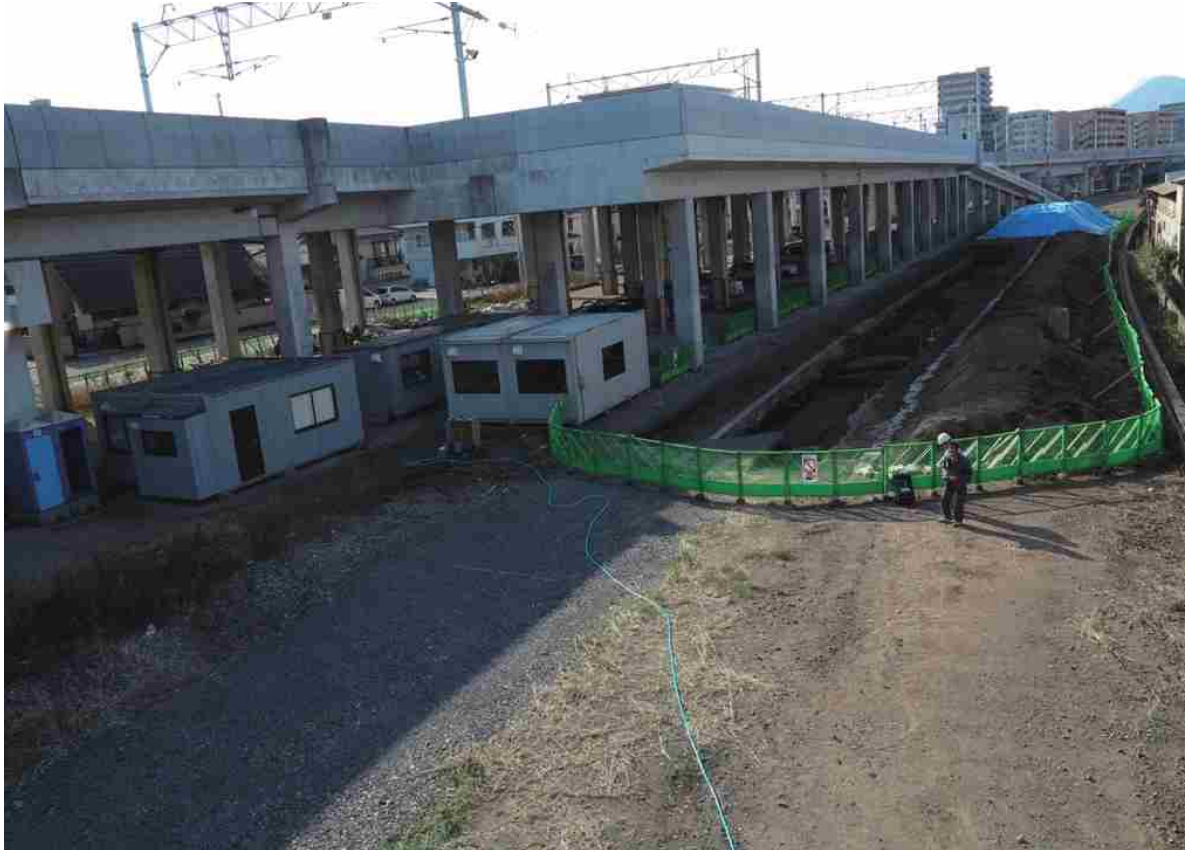
中世大友府内町跡第99次調査区全景(東から)
