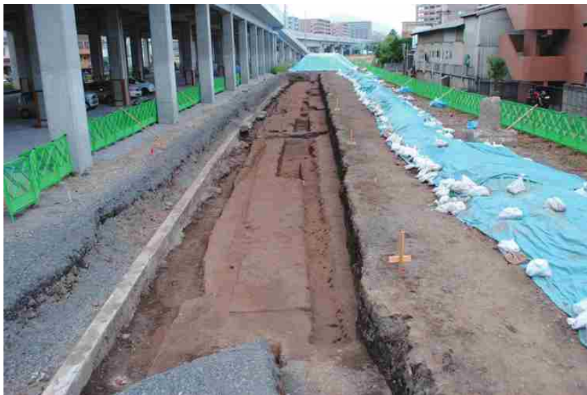
SD001完掘状況(東から)
