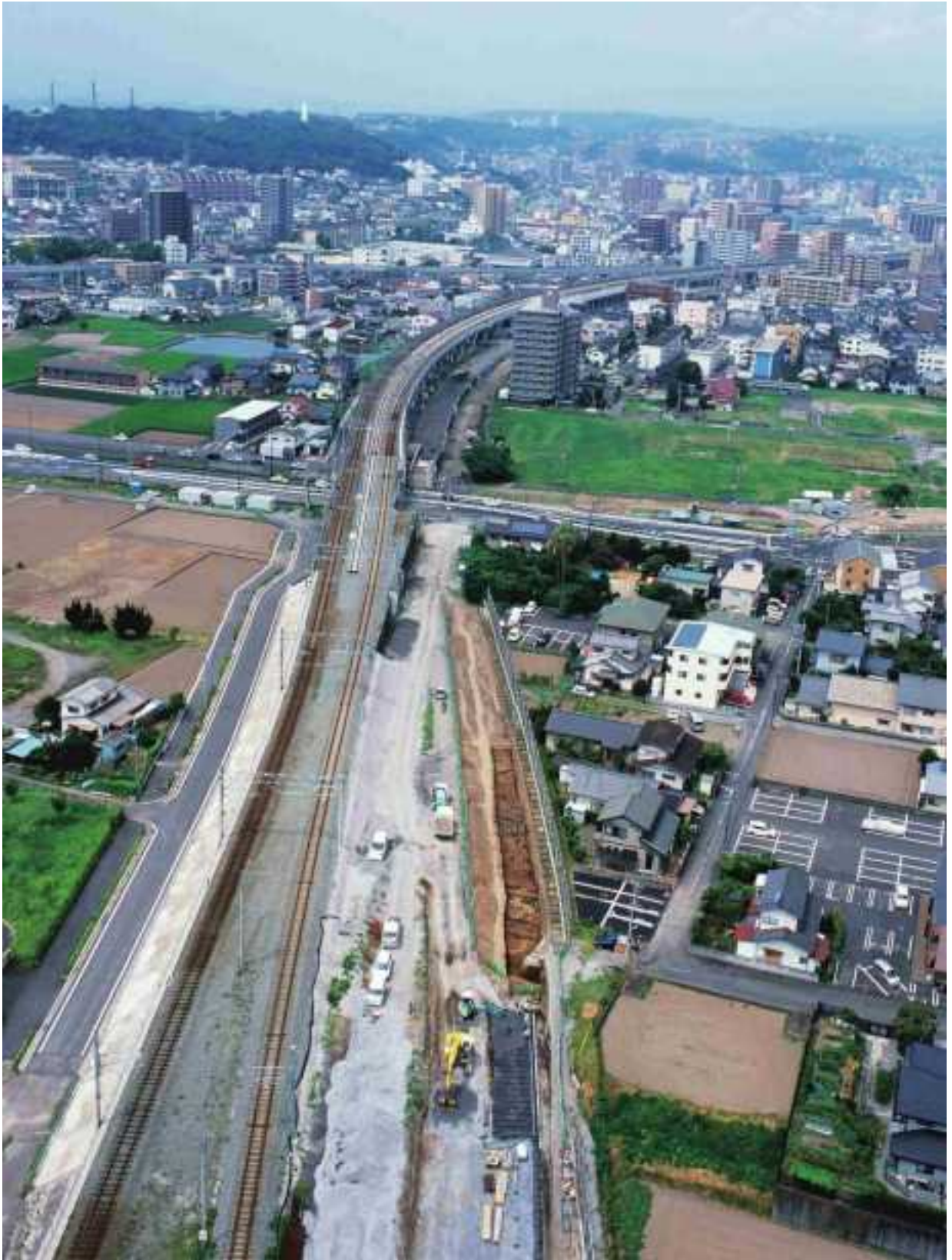
中世大友府内町跡第 96 次調査（東から）
