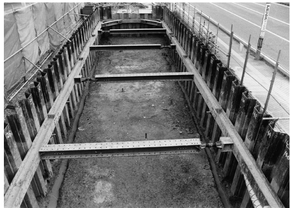
3 4地区遺構検出状況（西から）
