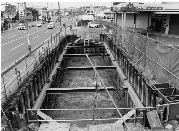
2 4地区全景（東から）
