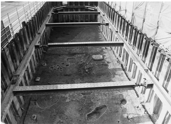
2 2地区全景（東から）
