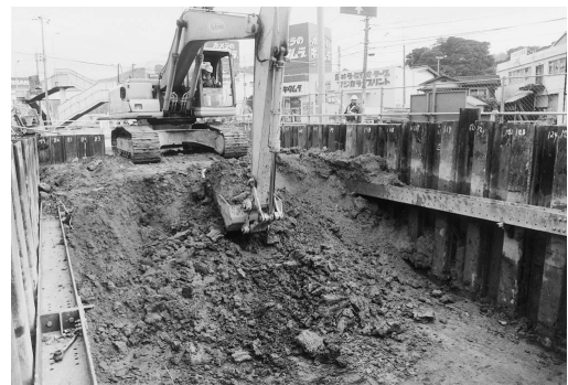
重機による表工除去作業
