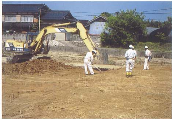
重機による表土除去
