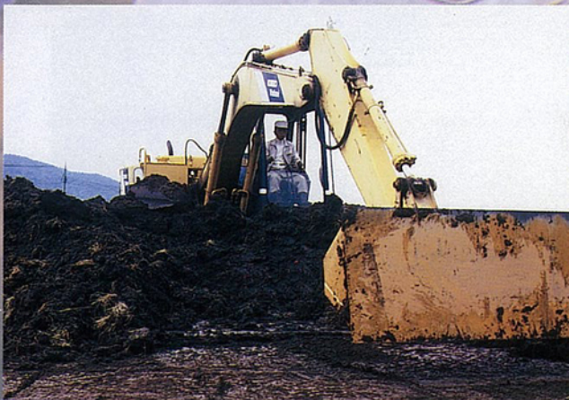
重機による表土除去作業風景
