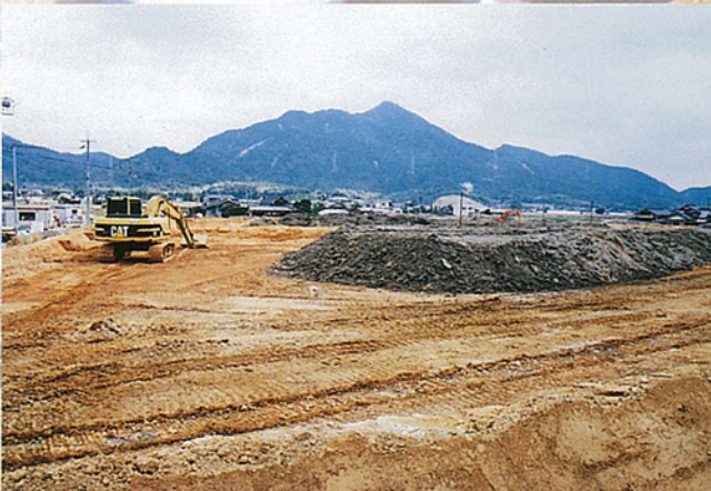
急ピッチで進むほ場整備工事
