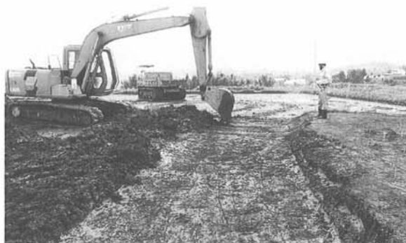
重機による表土除去作業
