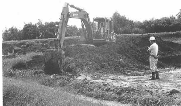
重機による表土除去
