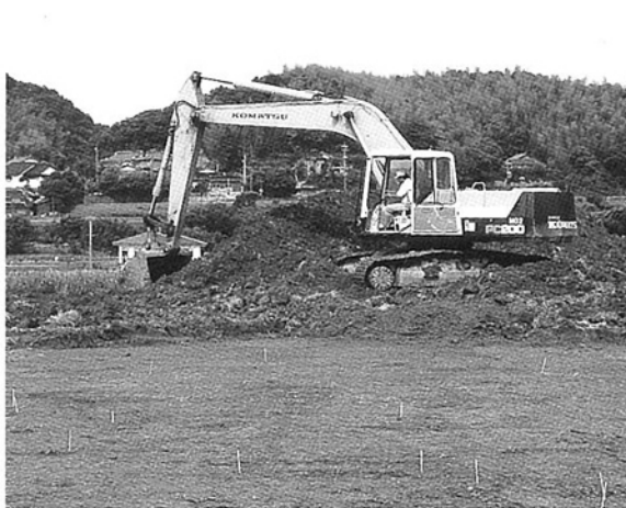
重機による表土除去
