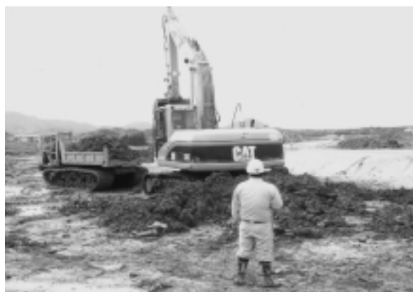
重機による表土除去
