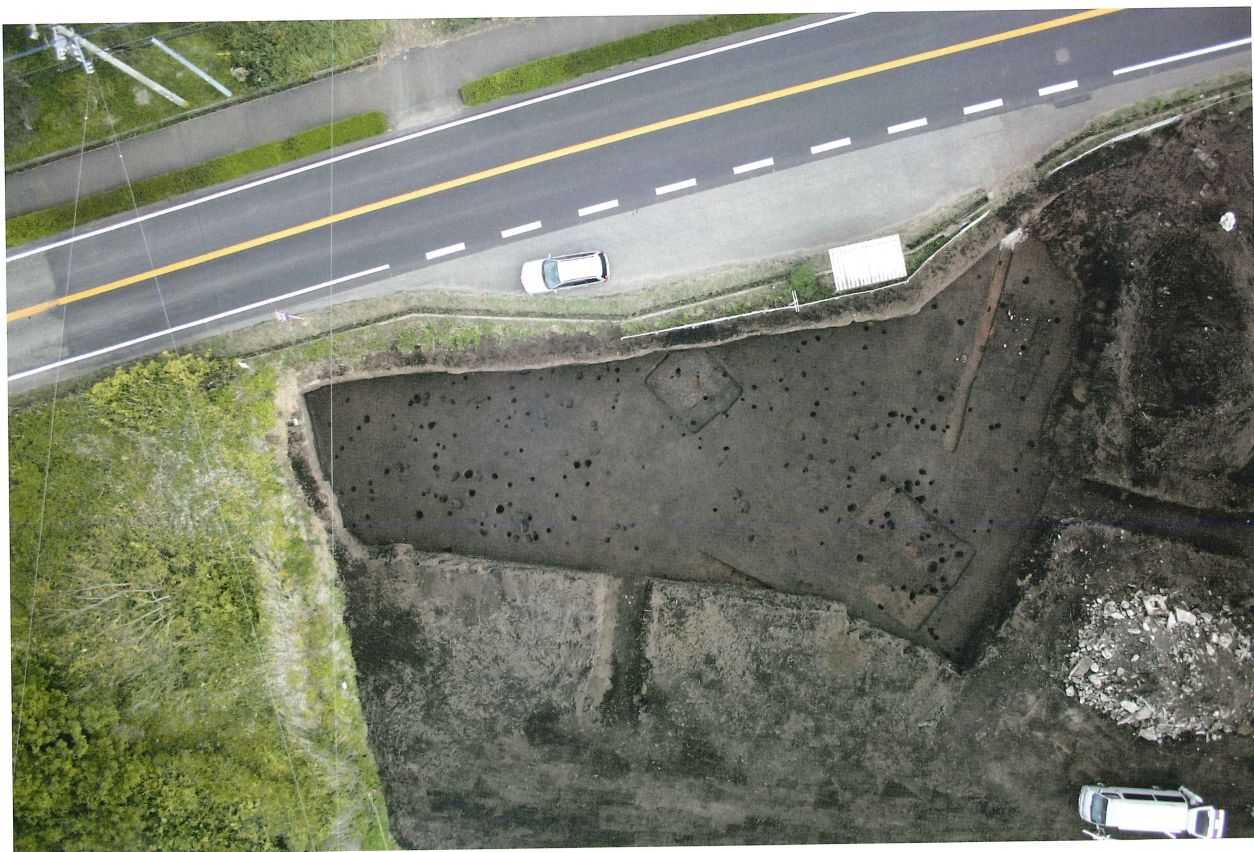
5次東半分（西から）
