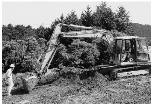
重機による表土除去
