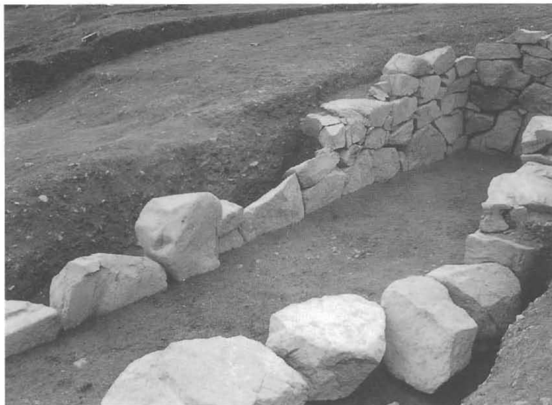
2. 左側壁 (南東から)
