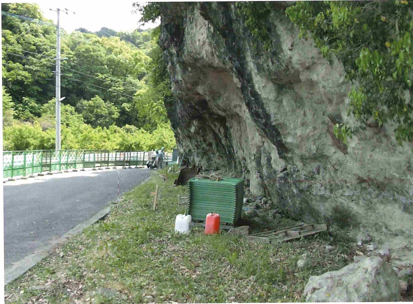
調査前の状況
