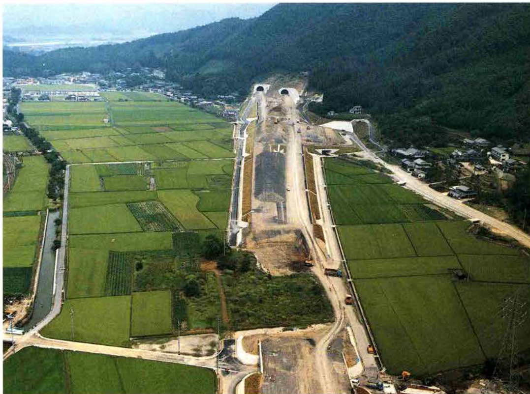
1. 調査前の初田館跡近景写真（南上空より）
