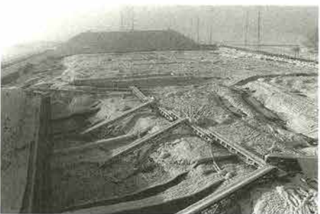
4. 旧河道の掘削
