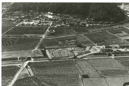
1. 遺構全景（東上から）
