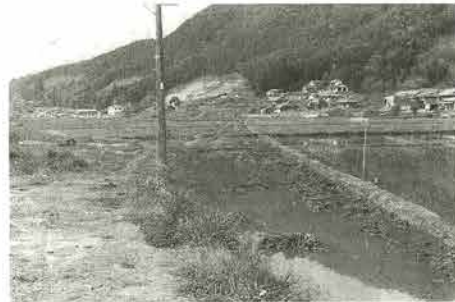
工事用道路予定地 (南から)
