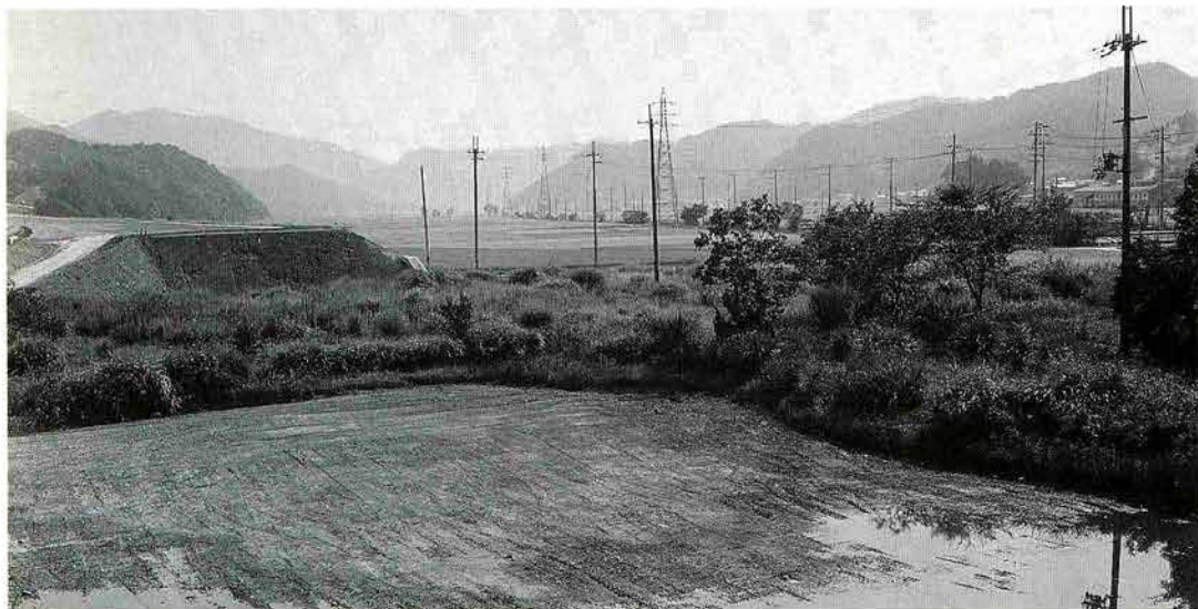
上：調査前の全景(南より) 中：伐採後の全景(北より) 下：調査前の全景(北より)
