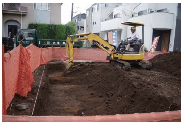
3. 表土剥ぎ風景
