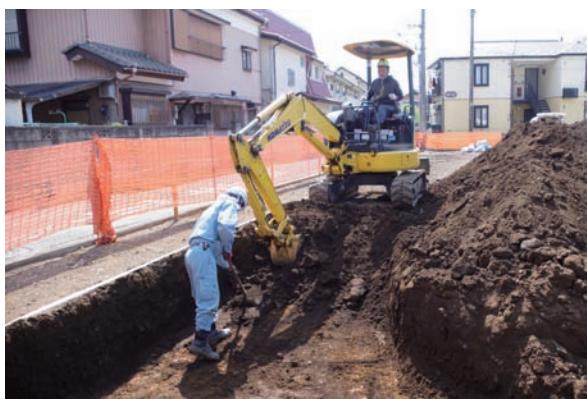
3. 表土剥ぎ風景
