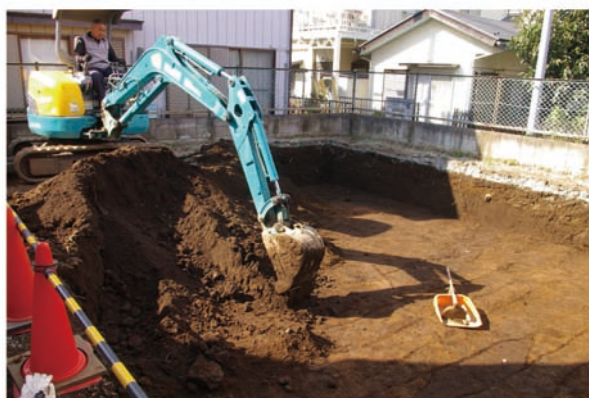
2. 表土剥ぎ風景
