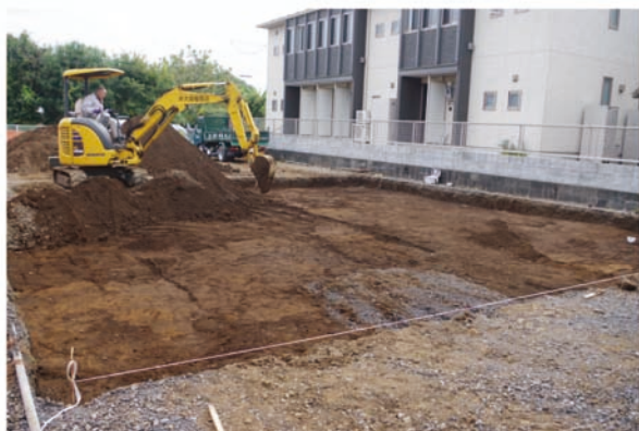
3. 表土剥ぎ風景
