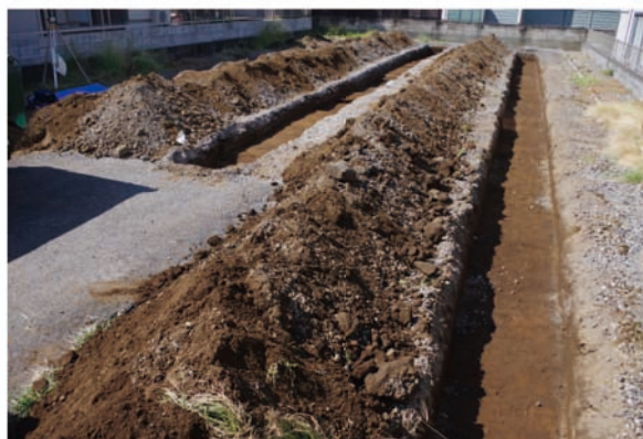
2. 確認調査風景
