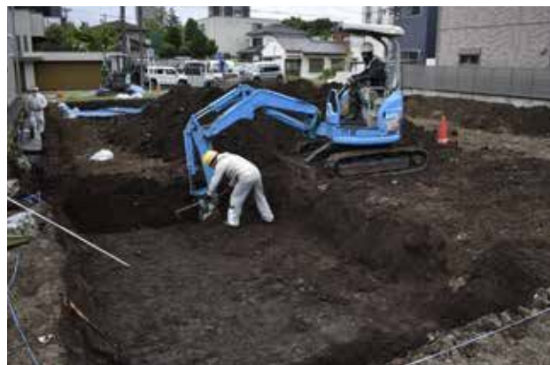
西区 重機掘削状況(北西から)
