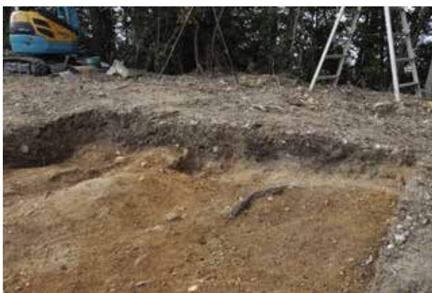
11 北壁断面(南東から)
