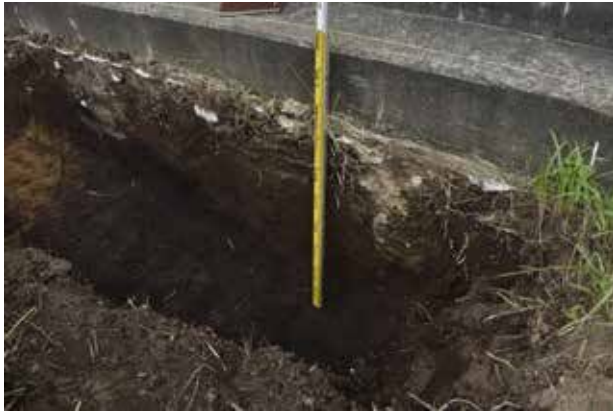
1 立会調査北区(南東から)
