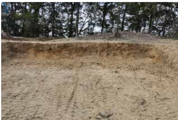
13 切土部南壁断面(南東から)
