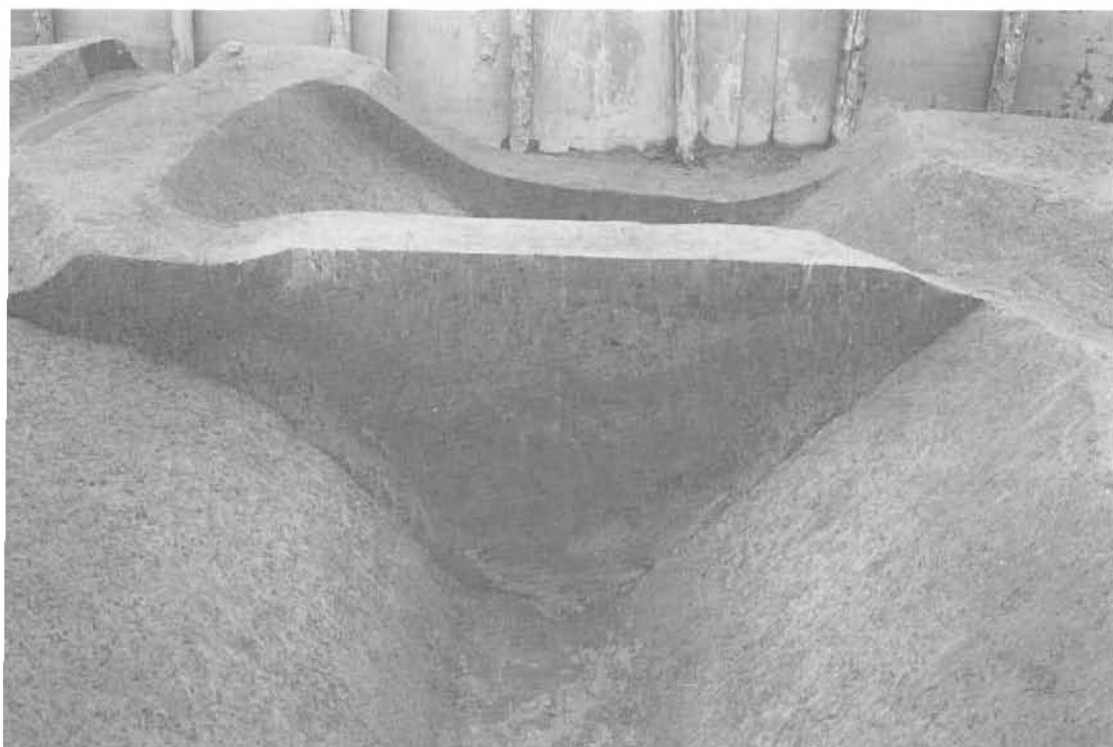
SD86 断面 (南西から)
