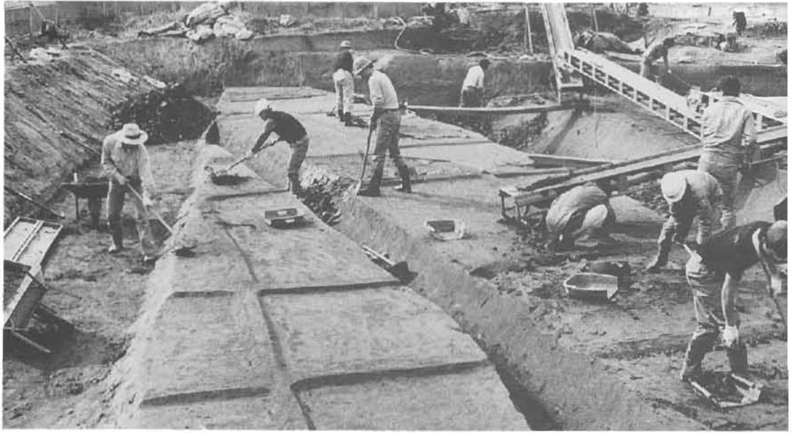
第4面検出中 (北東から)
