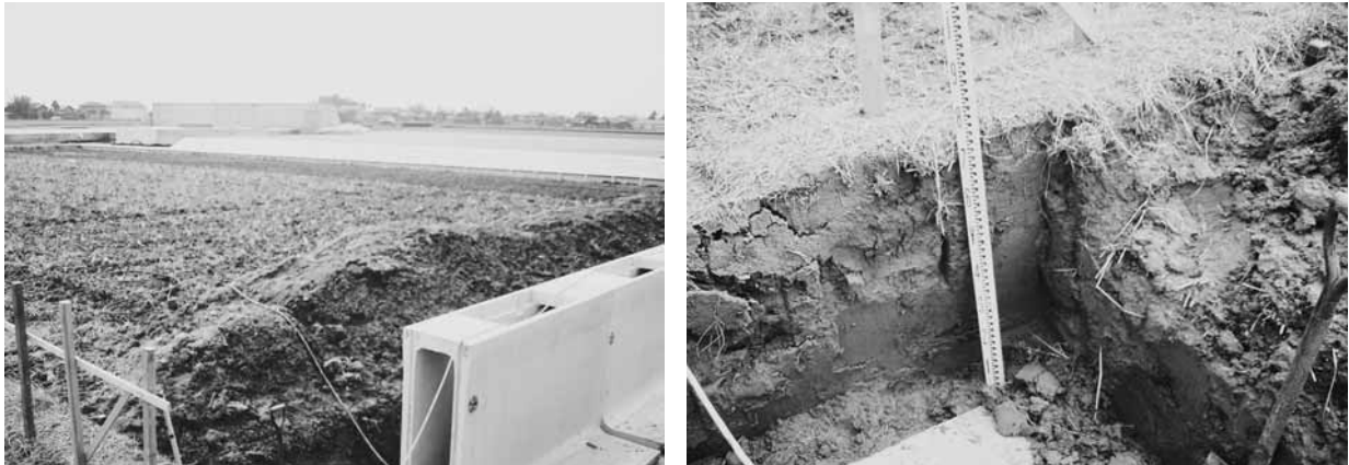
第26図 試掘坑③の周辺（左）・試掘坑③の断面確認状況（右）
