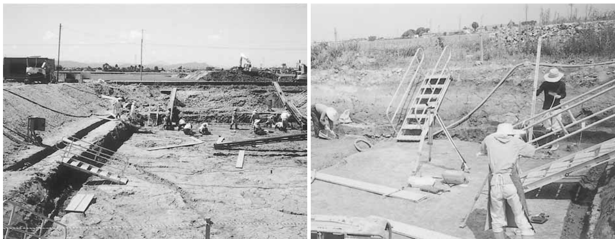
第5図 調査風景(左)調査区掘削状況(北から・8月2日) (右)北側遺物取り上げ状況(南から・8月26日)
