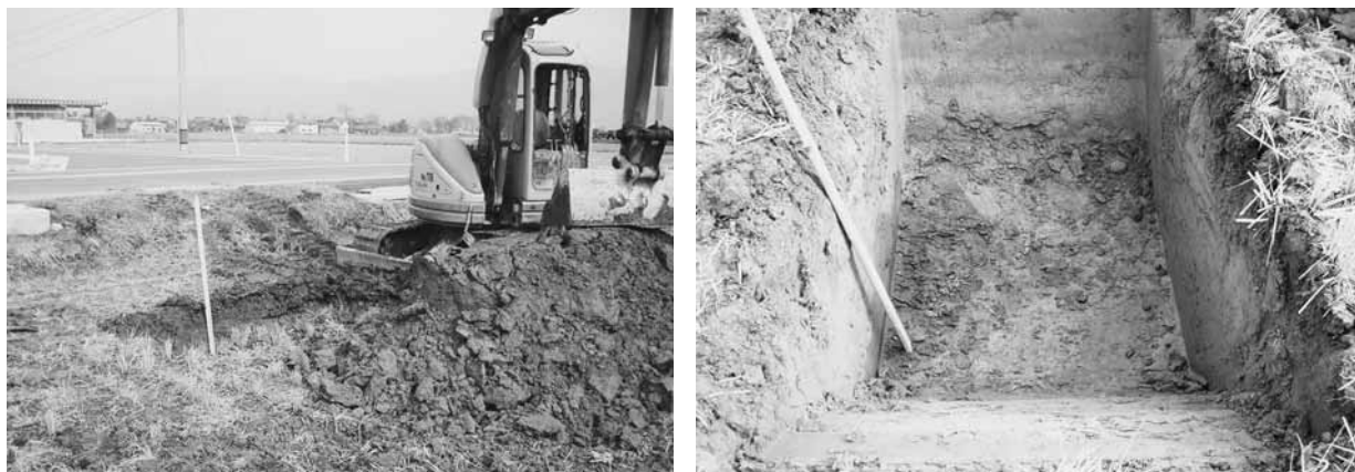
第25図 試掘坑②掘削状況（左）・試掘坑遺構確認状況（右）（左側に黒色の落ち込みが確認できる）
