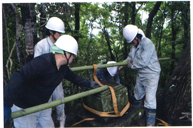
1号石塔撤去作業
