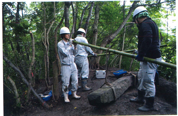
4号石塔撤去作業
