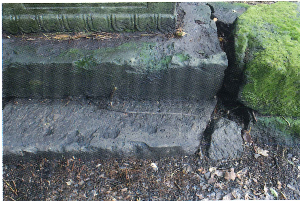
1号石塔南面基礎針金確認状況
