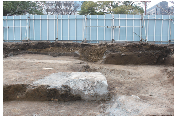
土層 1 〈中央南寄〉（東方向から）
