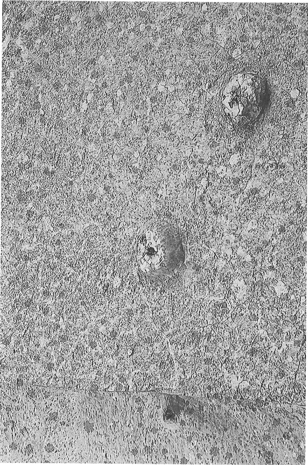
写真100 VSM-01検出状況 1 (西から)
