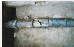
丸瓦を転用した樋管（排水管）
