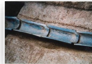
丸瓦を転用した樋管（排水管）
