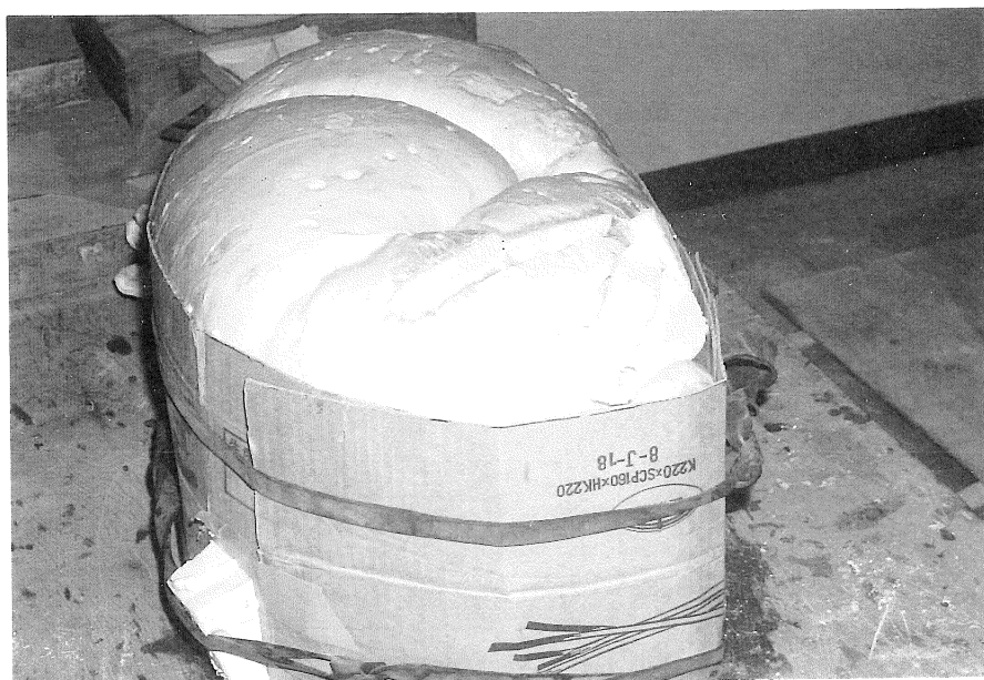
図65 発泡材ブロックの完成
