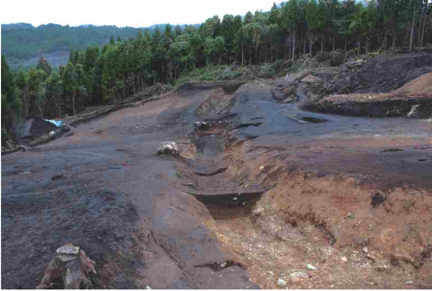
SD2東半部完掘状況
