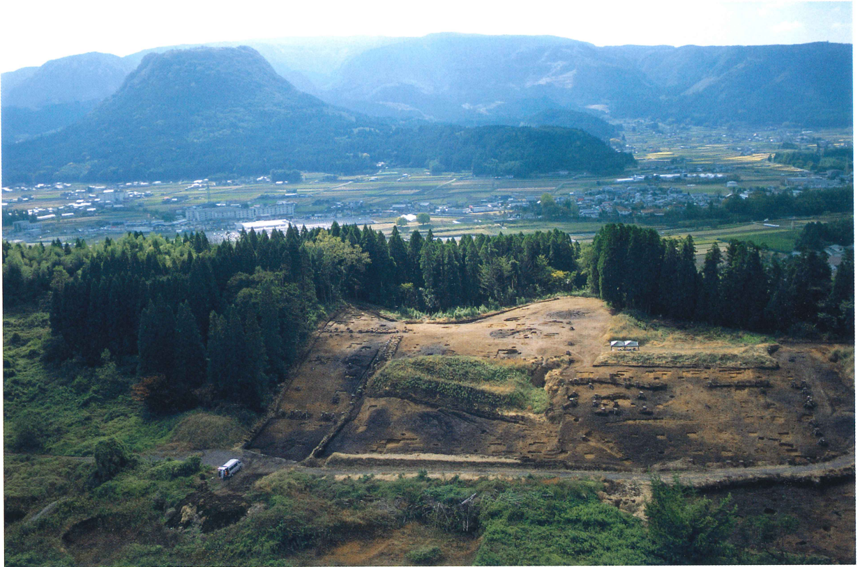
第14次調査区全景1（北より）
