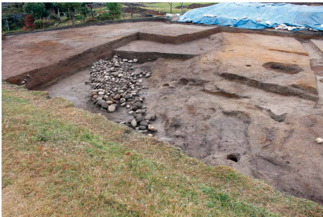
流路SR002掘削状況（北から）
