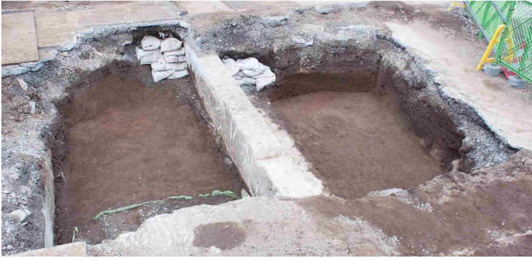
1次区域3全景（北方向から）
