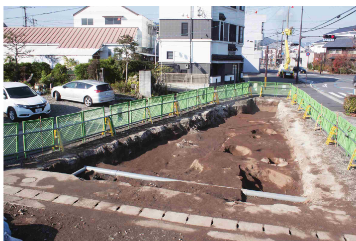
1次区域1全景(東方向から)
