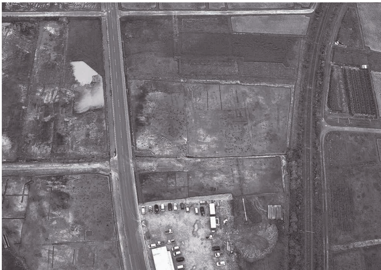
(1) 4区全景 (南方上空より)
