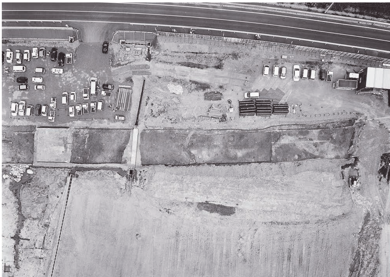
(1) 7区全景 (上空より 左が北)
