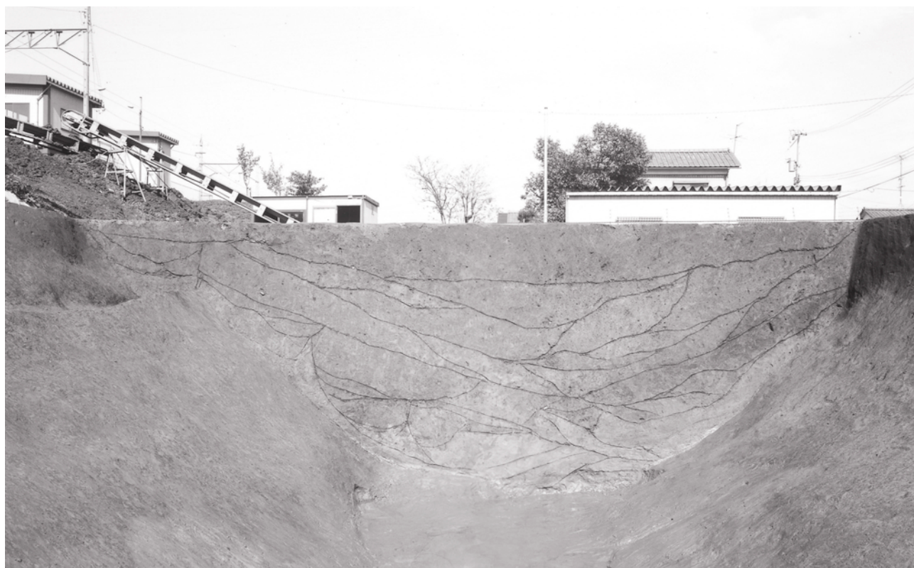
(2) 堀3断面 (南より)
