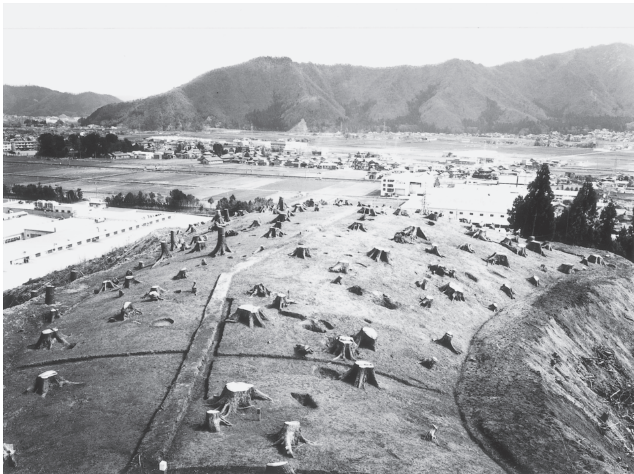
(1) 調査後の大塩向山遺跡C地区……調査区西端から
