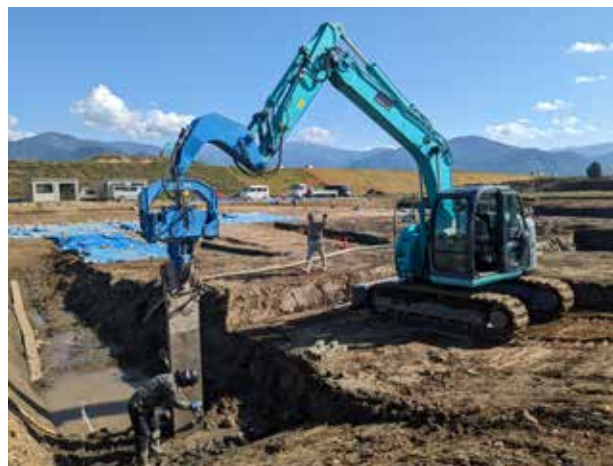
図3 地層抜き取り調査（ジオスライサー調査） （2023年・長沼城跡の中堀確認調査）
