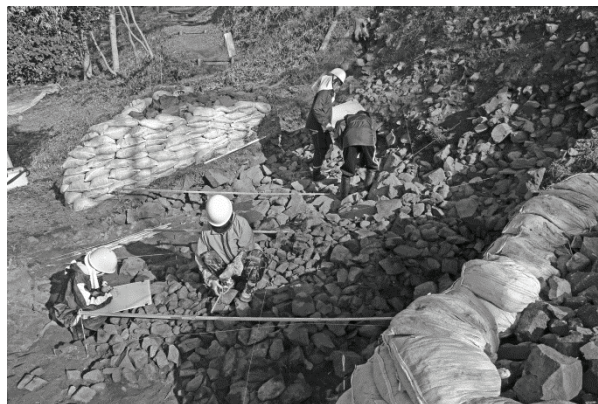
写真4 上段部 崩落石垣実測作業
