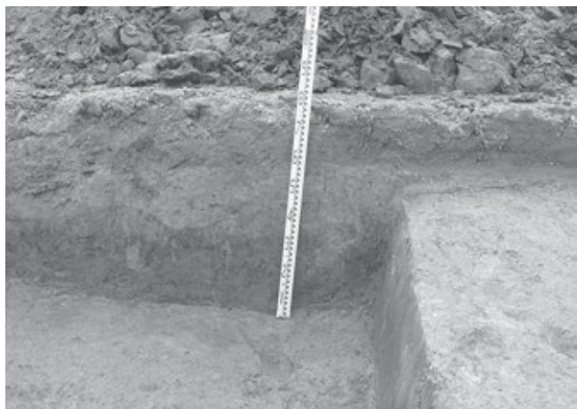
写真12 第4トレンチ掘削状況
