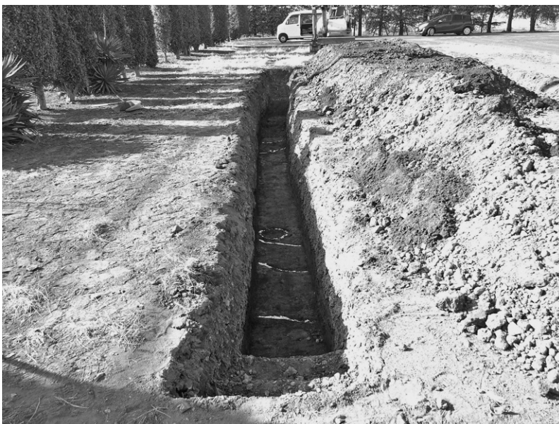
51 R 3 - No.639 龍舞深町遺跡（東から）
