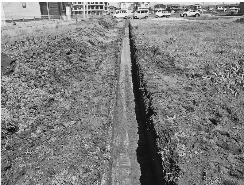
12 H29- No.17 FP 泥流下遺跡群 (南から)
