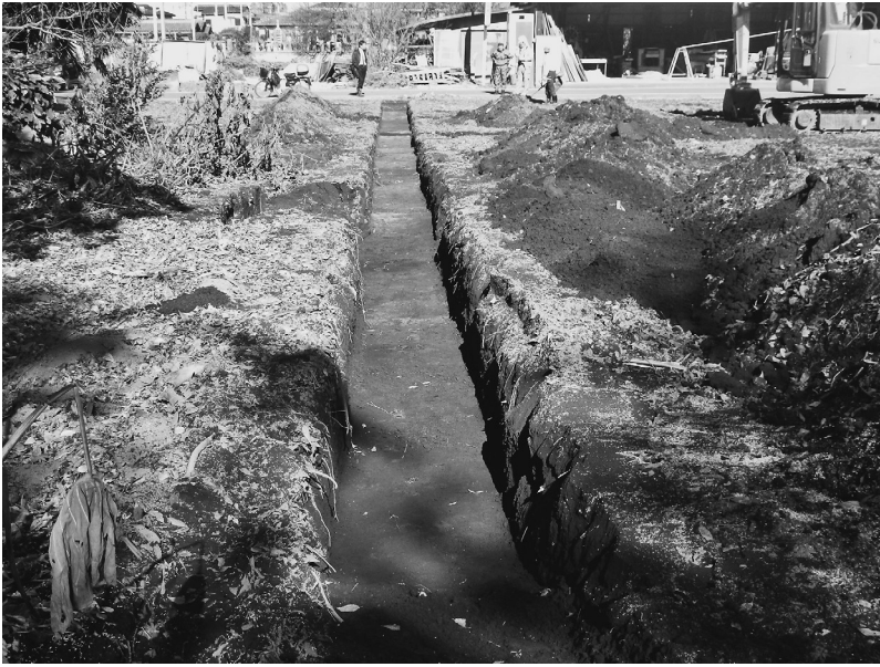
16 H29- No.94 北之庄遺跡（南から）
