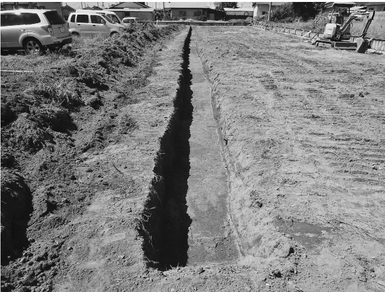
29 H29- No.642 大門遺跡（東から）
