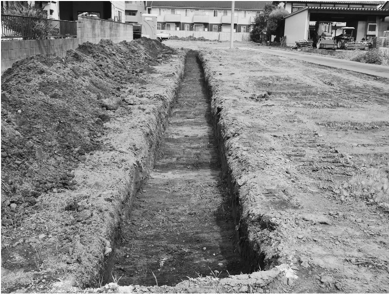
10 H29- No.553 FP 泥流下遺跡群 (南から)
