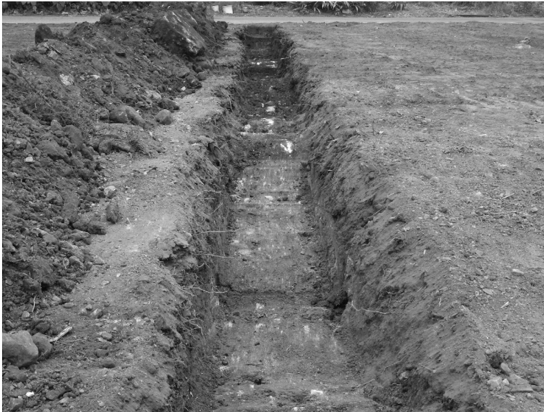
H26 No.436 境ヶ谷戸遺跡（南から）
