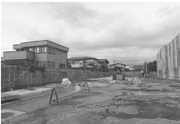
41 宮内遺跡 工事立会(南から)
