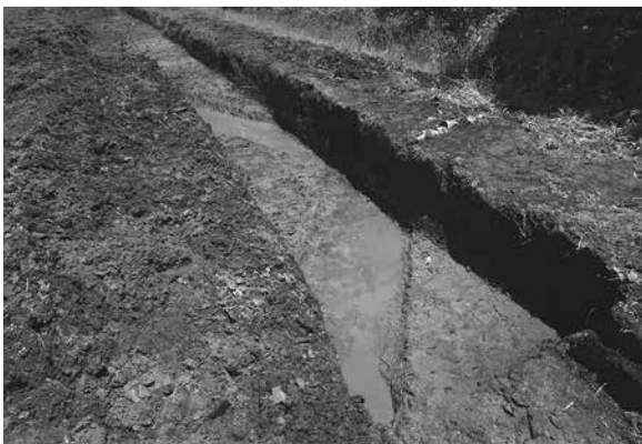
SD10 完掘状況 (南西から)
