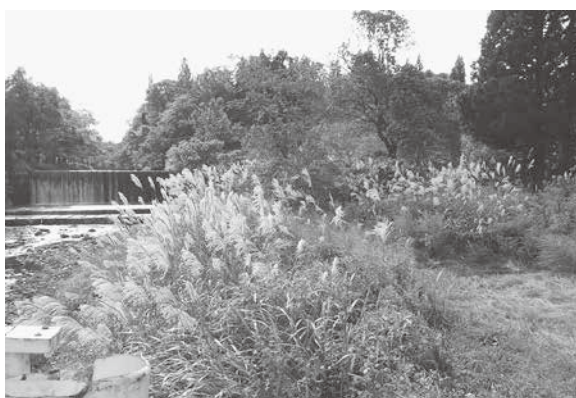
62 小川沢砂防堰堤(北から)
