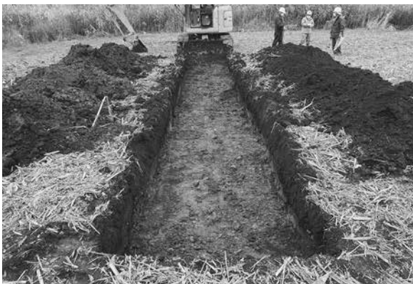
T 16 全景 (南から)
