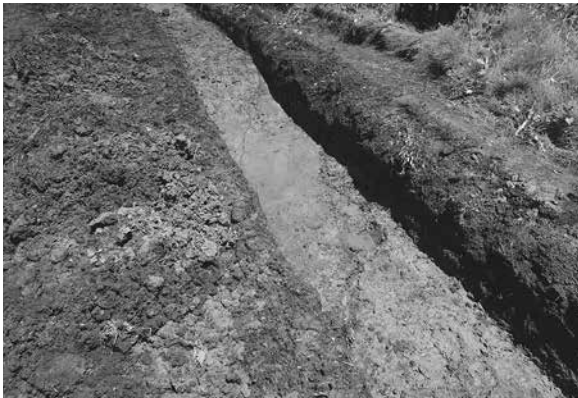
SD 9 完掘状況 (南西から)
