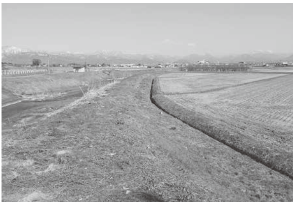
34 古佐川河川整備補助事業 (防災安全) 築堤工 (西から)
