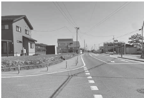
26 山形朝日線歩道設置工事山辺工区 (南から)
