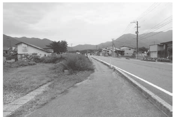
50 一般国道 47 号志茂歩道整備事業 (東から)
