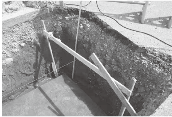
24 鶴巻遺跡 工事立会 (西から)
