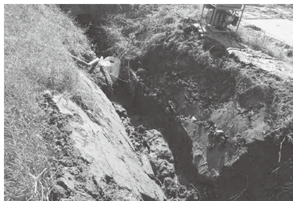
18 新青渡遺跡 工事立会 (北西から)
