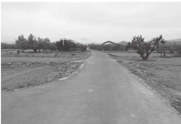
42 最上川上流大規模関連災害事業(溝延築堤)(西から)
