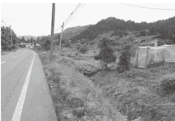
29 山形南陽線板宮工区 (南から)
