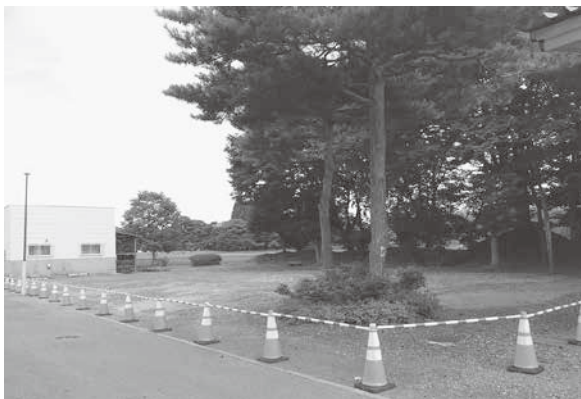
38 米沢養護学校高等部就労コース設置事業 (北西から)
