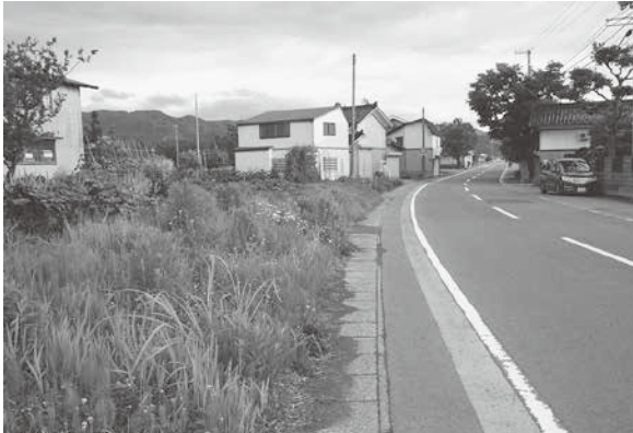
32 主要地方道余目温海線 (黒川)(北から)
