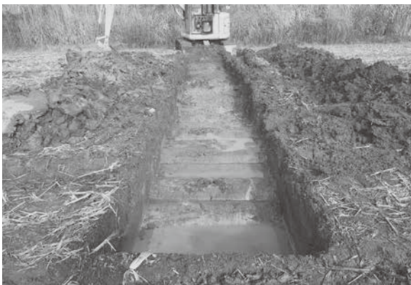
T 12 全景 (南から)
