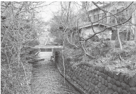
33 荒町川河川整備補助事業 (南東から)
