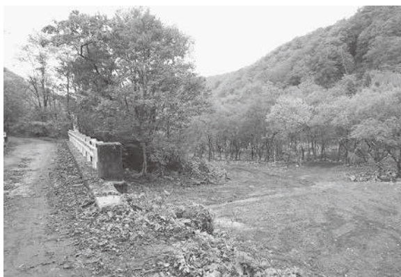
63 穴淵砂防堰堤(東から)
