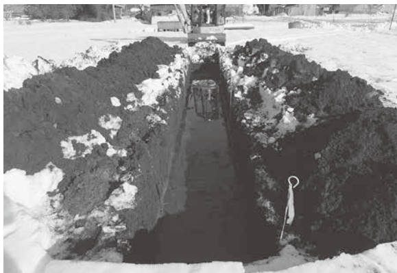
T 11 全景 (南から)
