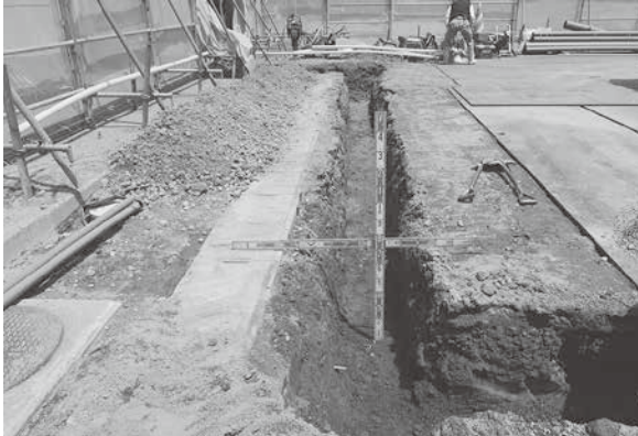
39 庄内中高一貫校(仮称)校舎整備工事立会(南から)
