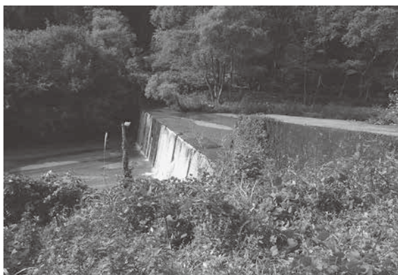
61 樋ノ沢第1砂防堰堤(北東から)
