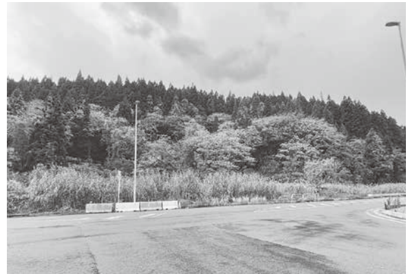
48 一般国道 47 号高屋防災道路 (北東から)
