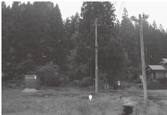
60 入水ノ沢砂防堰堤(鮭川砂防)(南東から)
