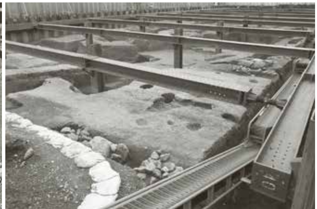
(4) 砂利敷道路1 3 面目 (北から)
