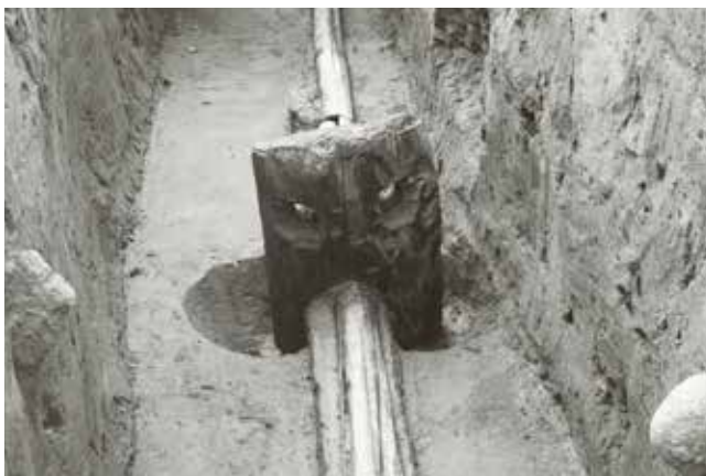
(4) 上水路 2-31 継ぎ手 (東から)
