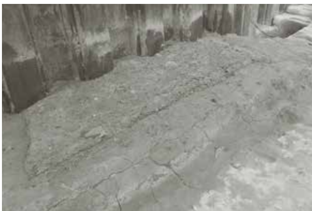
(2) 砂利敷道路2 (南東から)
