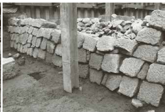
(3) 石垣 2-45 (南東から)
