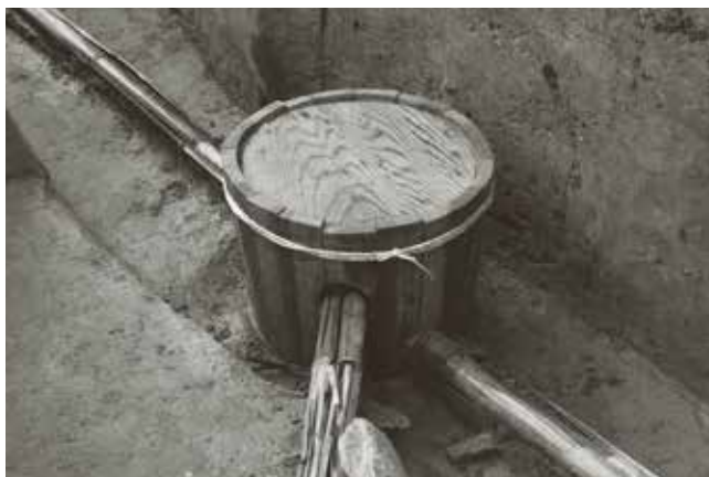
(5) 上水路 2-31 桶 (南東から)
