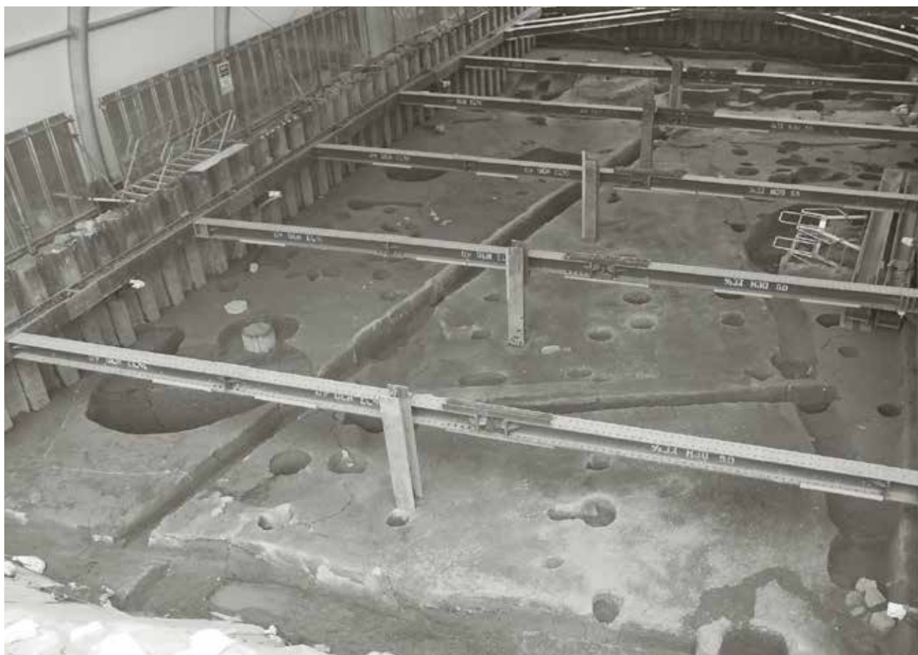
(2) 砂利敷道路3(南から)
