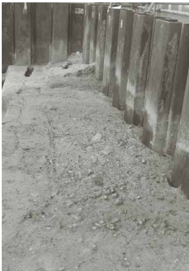
(1) 砂利敷道路2 (北から)
