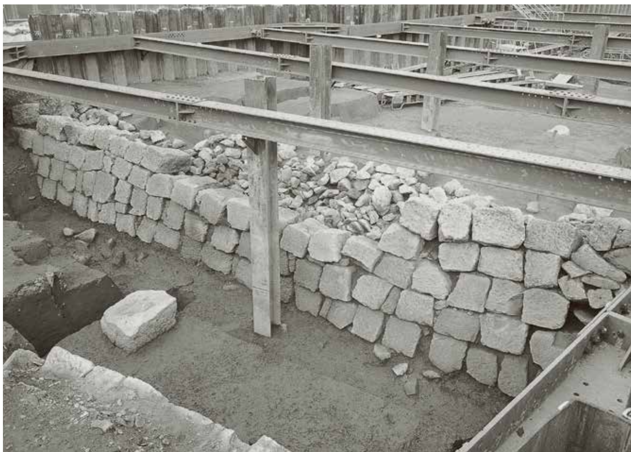
(1) 石垣 2-45 (南東から)
