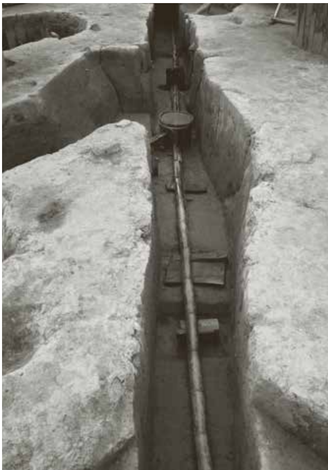
(2) 上水路 2-31 (東から)
