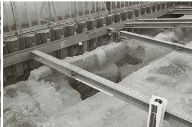
(5) 土坑5-88 (南東から)
