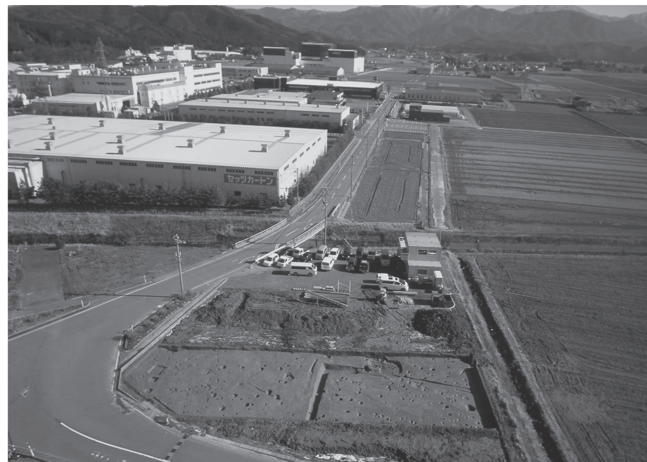
(1) I区(平成27年度調査区)近景(西から)
