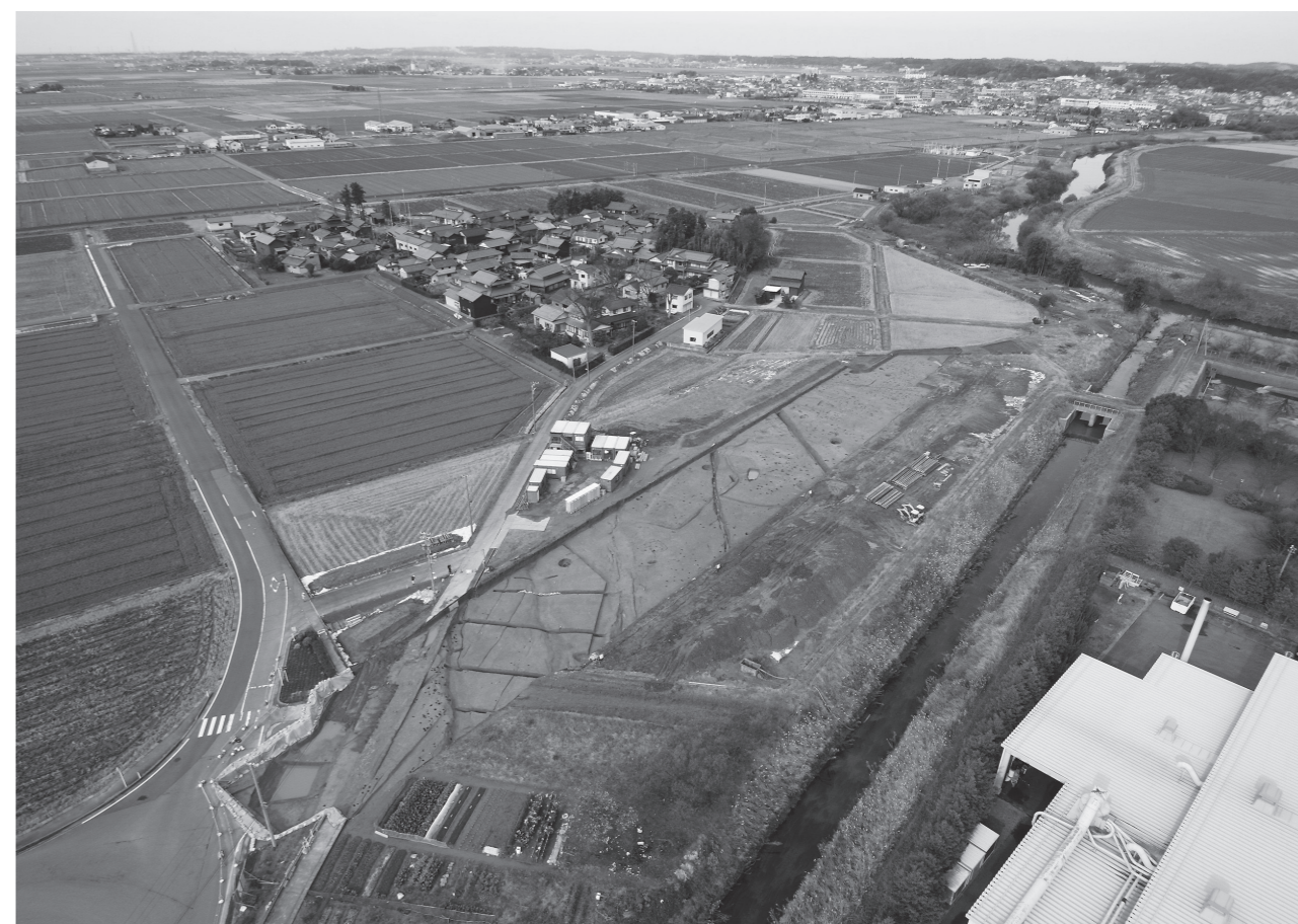
(2) II区(平成28年度調査区)近景(南東から)
