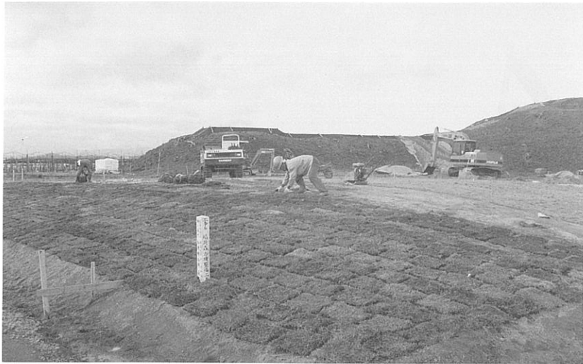
1 張芝工事作業 状況 (平成2年度)
