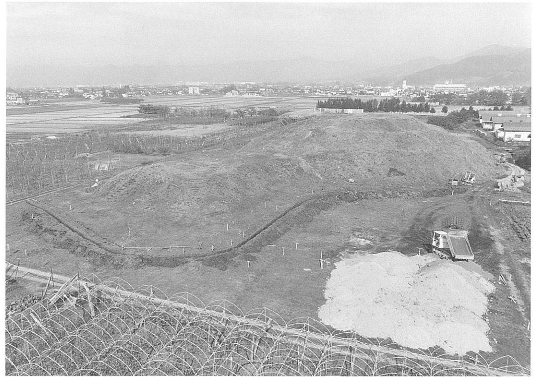
1 着工時全景（平成元年度、東南から）
