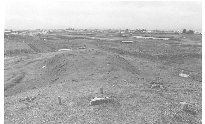
1 工事前状況 (後円部から前方 部を望む)
