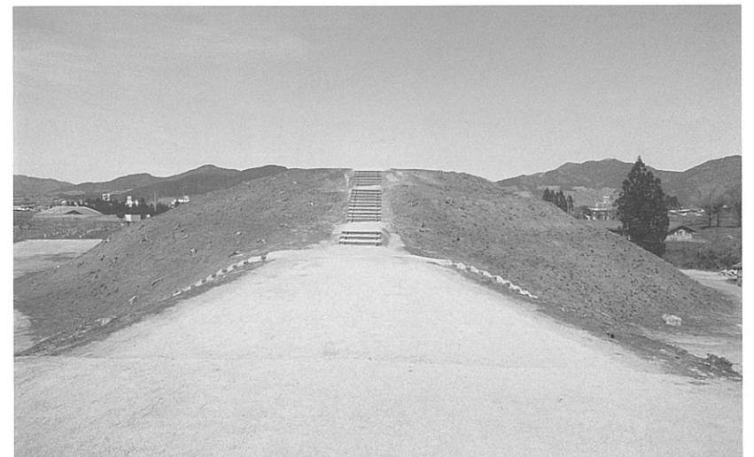
図版5 墳頂部盛土・階段工事(1)(平成2年度)
