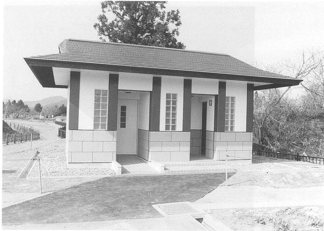
1 便所全景（南から）
