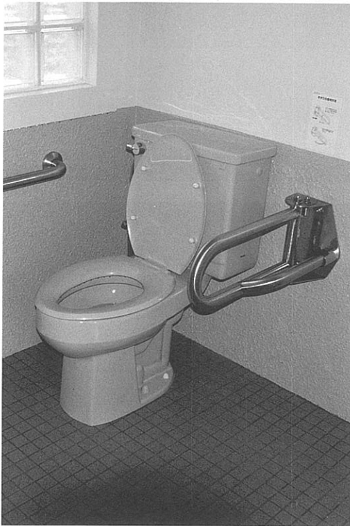
2 身体障害者用トイレ
