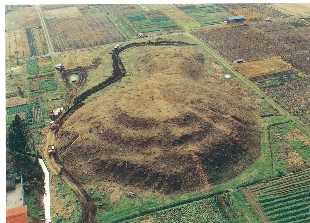
2 着工時全景 (平成元年度、北東から)
