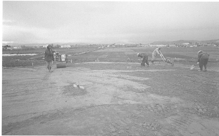
2 盛土・てん圧 作業 (南東から)
