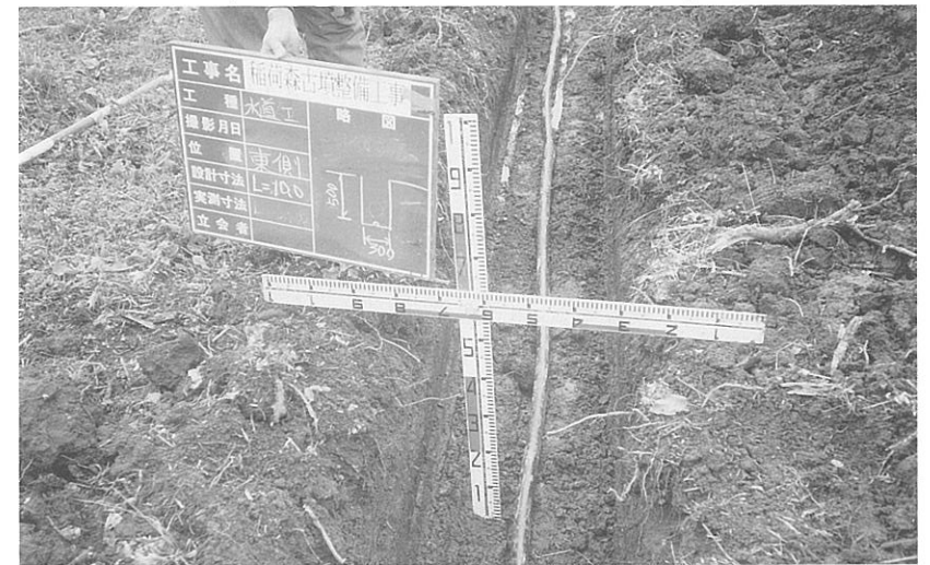
3 給水工事状況
