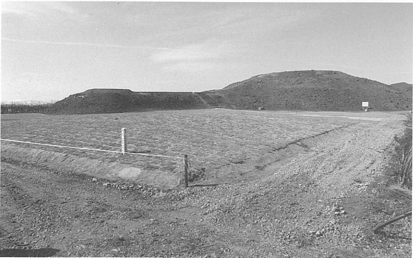
2 張芝工事完了 状況① (平成2年度)
