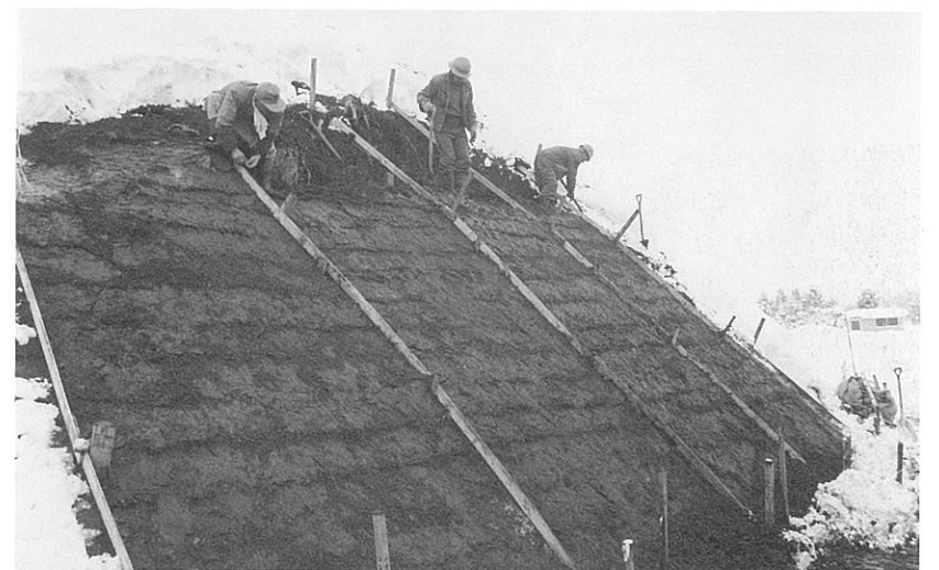
2 盛土・てん圧 作業
