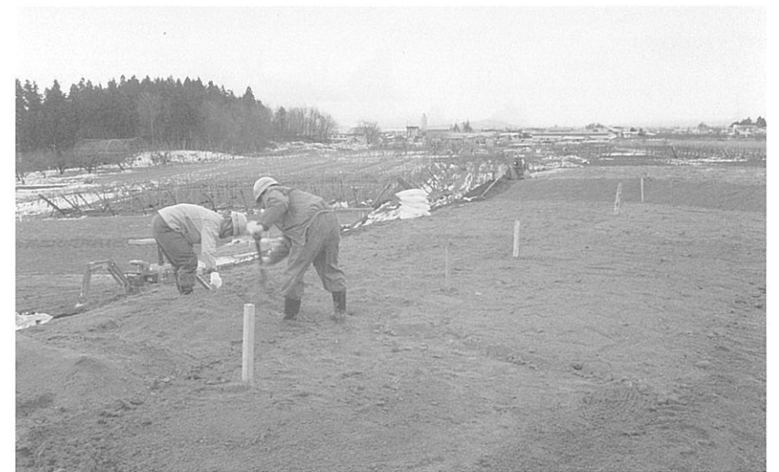
2 前方部頂盛土 作業
