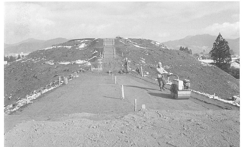
2 前方部頂盛土で ん圧作業
