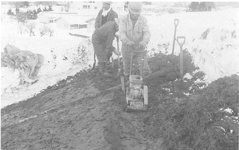
2 盛土・てん圧作業
