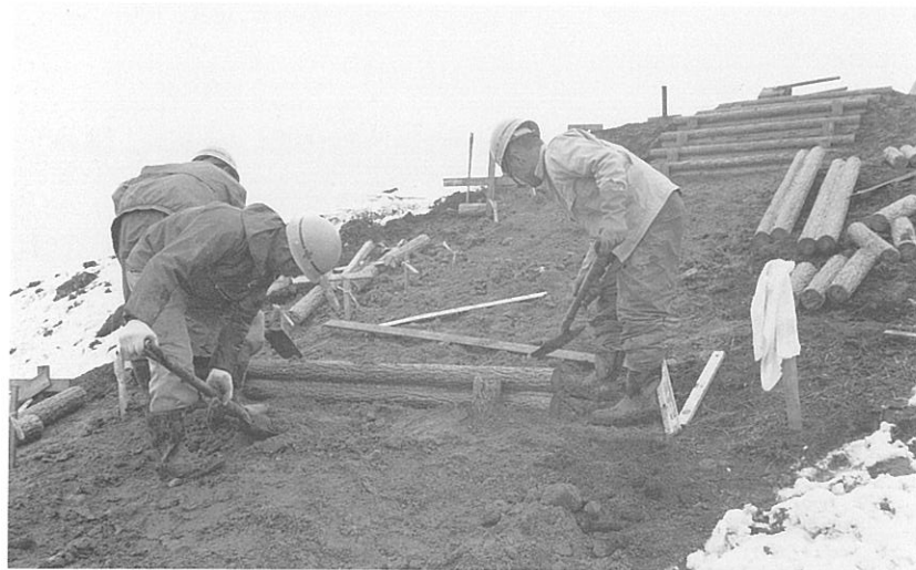
1 後円部階段工事 作業状況
