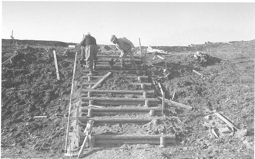
2 くびれ部東側 階段工事作業 状況
